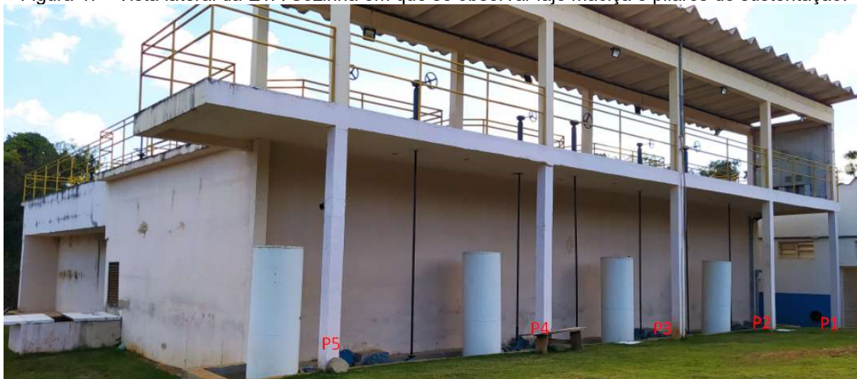
Figura 47 - Vista lateral da ETA Sozinha em que se observar laje maciça e pilares de sustentação.
