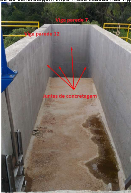
Figura 60 - Juntas de concretagem impermeabilizadas nas vigas parede 7 e 12.
