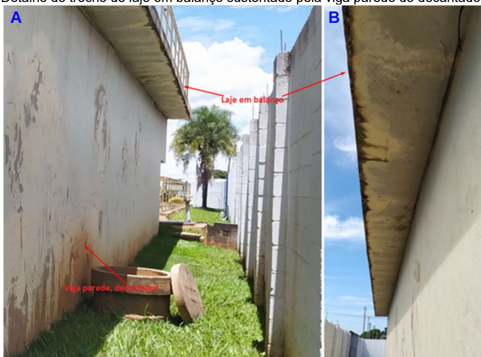
Figura 31 – Vista lateral do decantador. A) Detalhe da viga parede e trecho de laje em balanço. B) Detalhe de trecho de laje em balanço sustentado pela viga parede do decantador.
