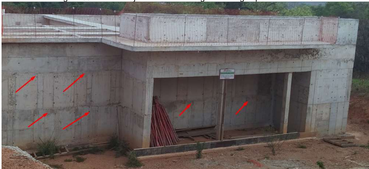
Figura 63 - Vista das juntas de concretagem nas vigas paredes 12 e 13.
