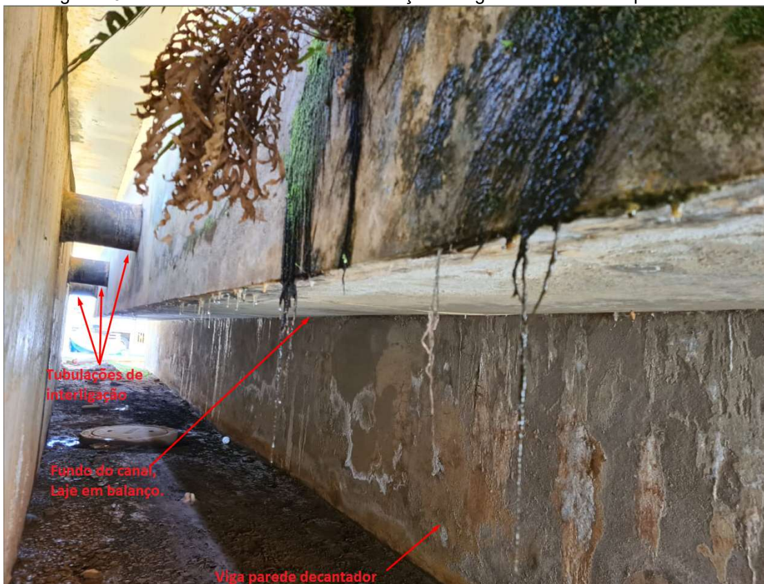
Figura 29 - Vista lateral do canal de distribuição de água do decantador para o filtro.
