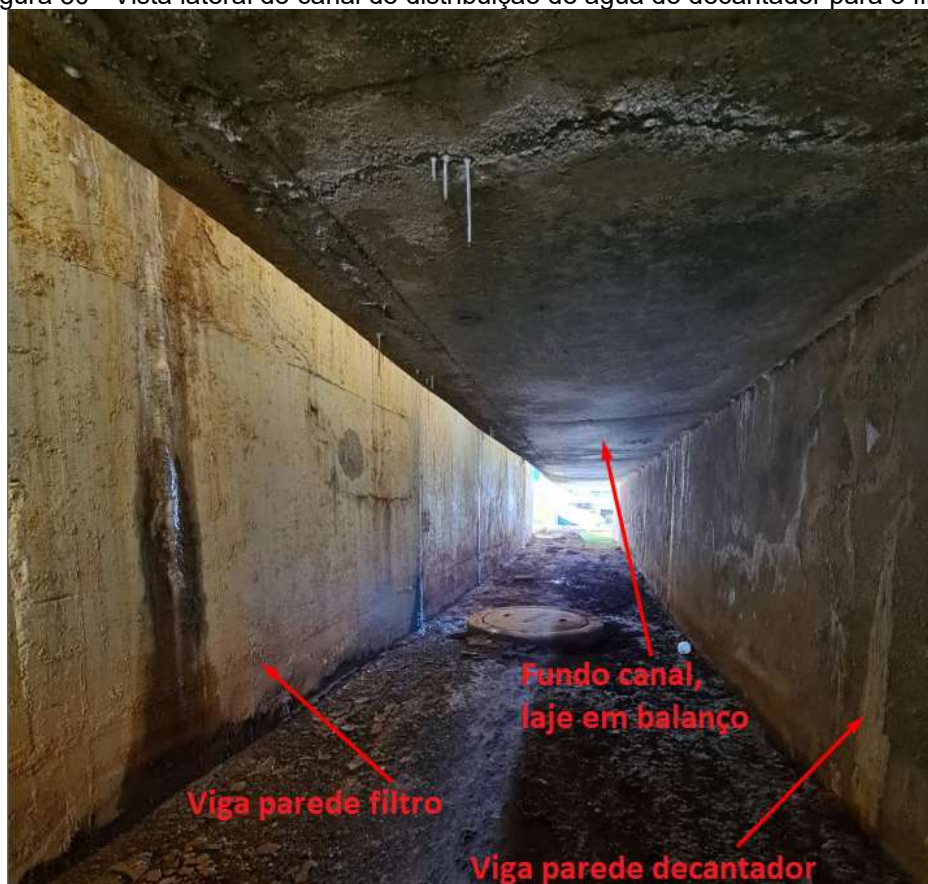
Figura 30 - Vista lateral do canal de distribuição de água do decantador para o filtro.
