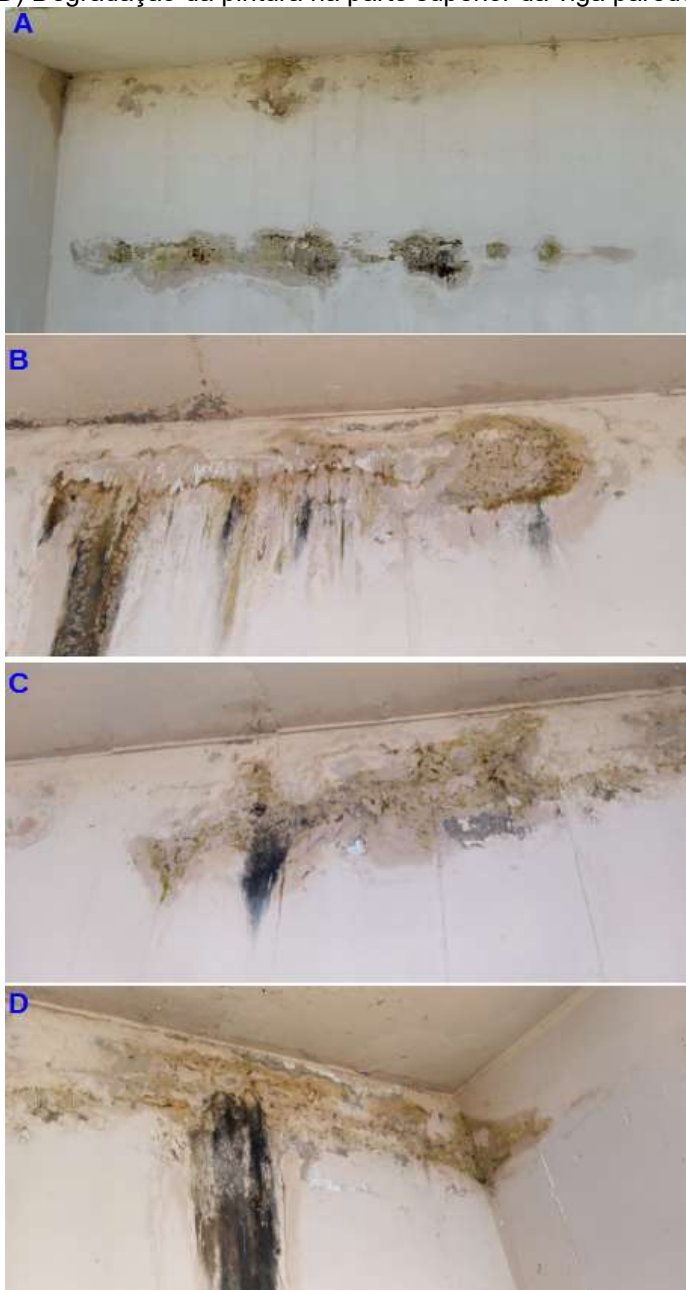
Figura 51 – Manifestações patológicas na viga parede 19. A) Deslocamento, empolamento e sujeidade na pintura no meio e na porção superior. B) Deslocamento, empolamento e sujeidade na pintura na parte superior da viga parede. C) Outro ponto com degradação da pintura devido a elevada umidade. D) Degradação da pintura na parte superior da viga parede.
