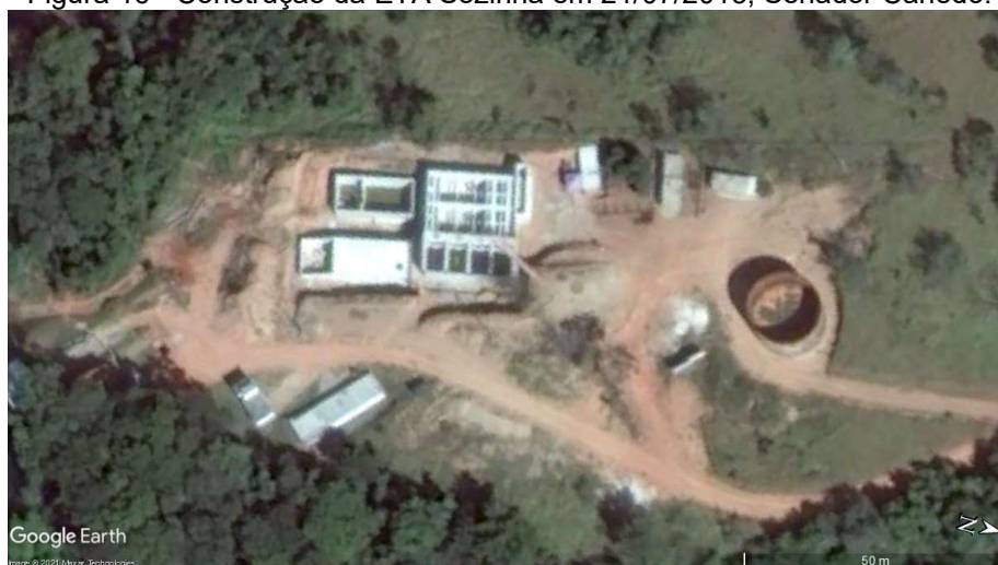
Figura 16 - Construção da ETA Sozinha em 21/07/2015, Senador Canedo.
