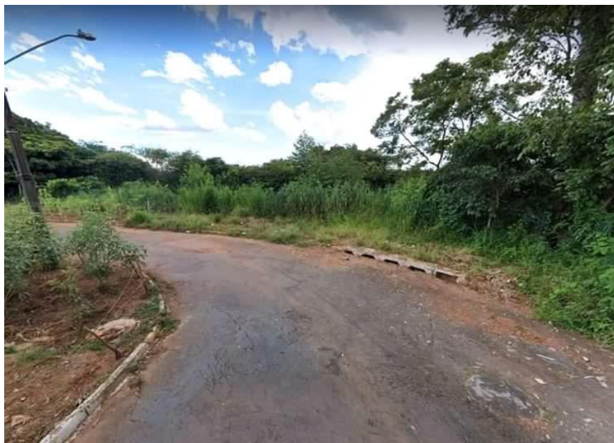
Figura 24. Boca de lobo em ponto baixo da sarjeta.
