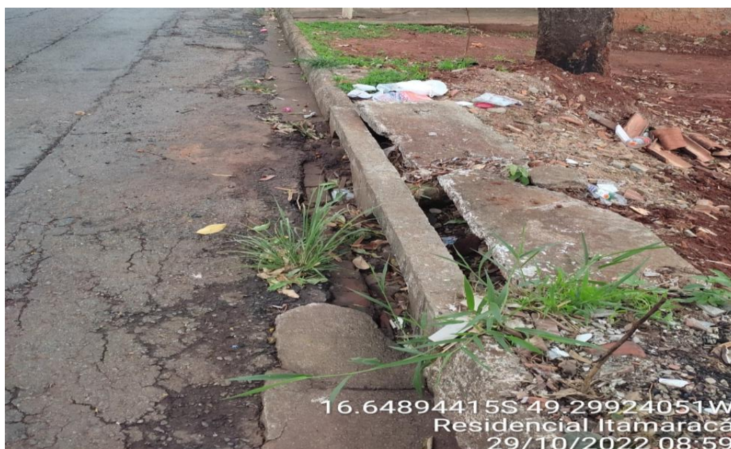
Figura 17. Boca de lobo Rua SP 1, Residencial Itamaracá.
