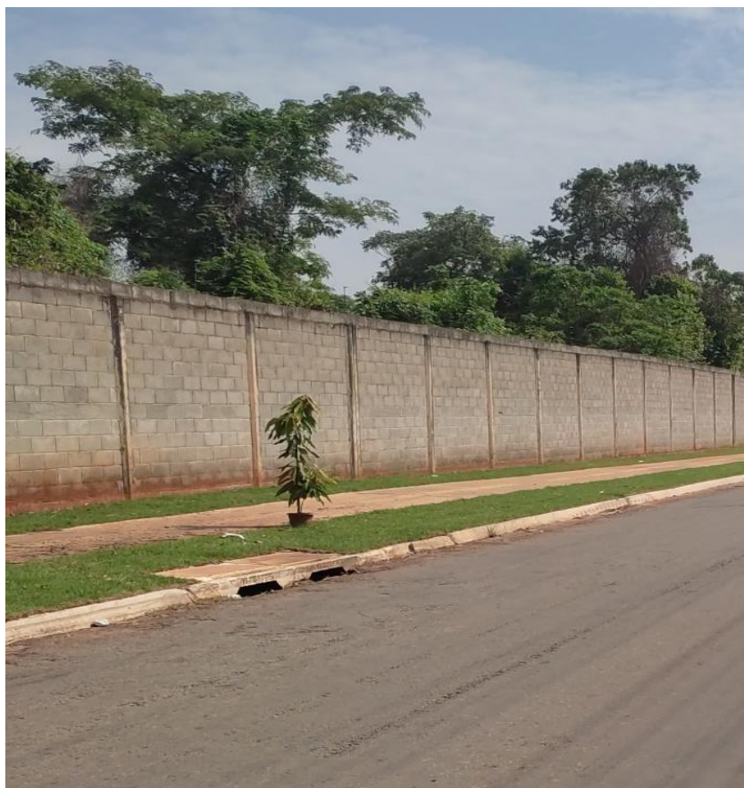
Figura 23. Boca de lobo em ponto intermediário.
