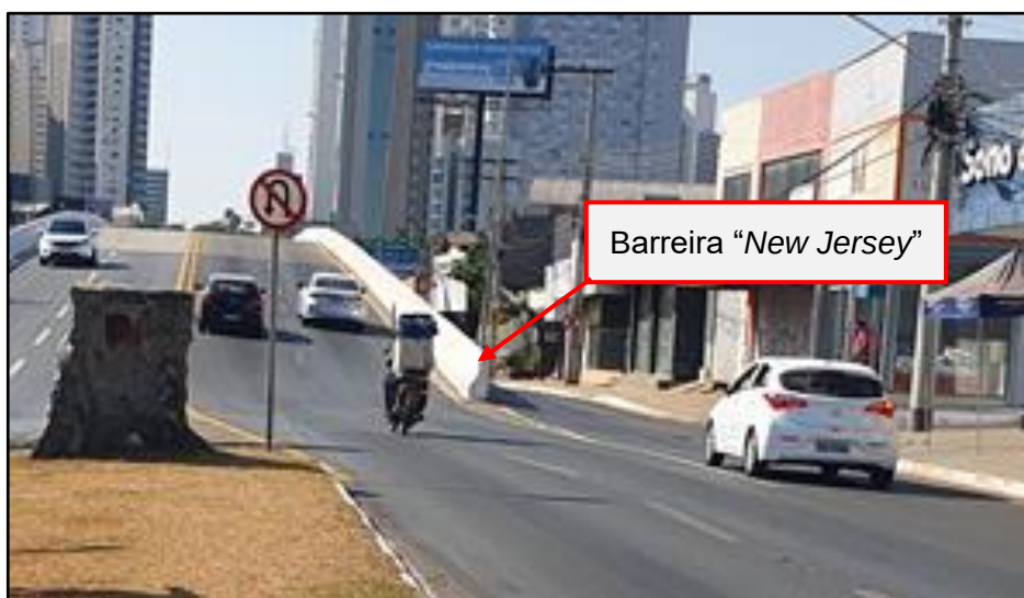
Figura 61 - Barreira "New Jersey" na lateral do viaduto.
