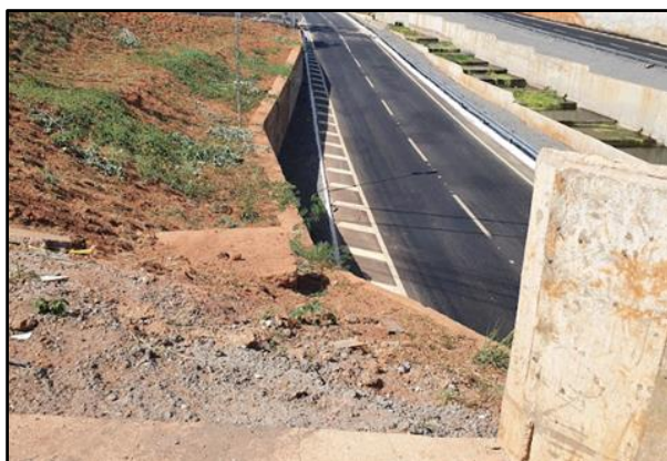
Figura 44 - Perigo na passagem de pedestres.
