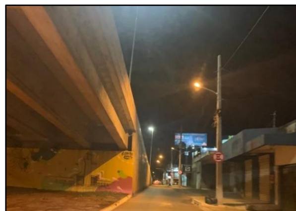
Figura 52 - Iluminação na alça do viaduto.
