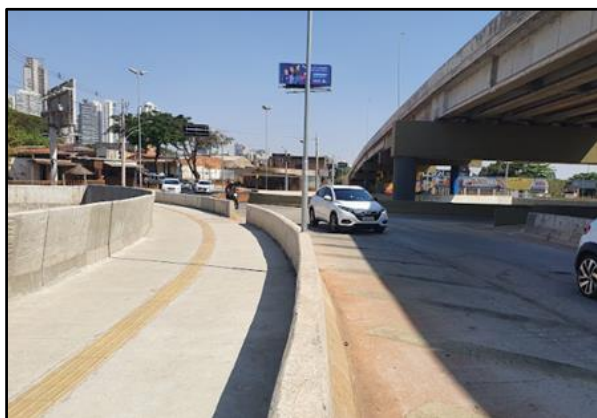
Figura 42 - Passagem de pedestres na alça do viaduto.
