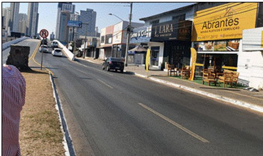
Figura 55 - Imagem do acesso e saída do viaduto com o estreitamento de pista.
