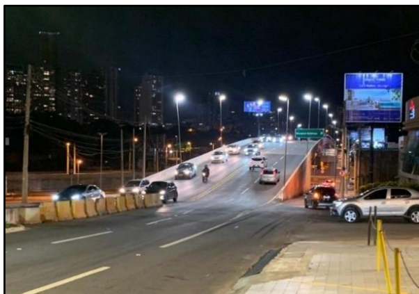
Figura 49 - Iluminação no viaduto.
