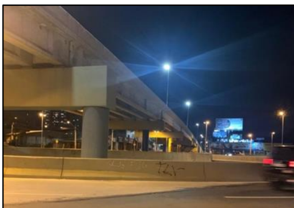
Figura 51 - Iluminação na rotatória.
