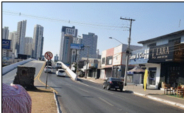
Figura 28 - Irregularidade no alinhamento horizontal na entrada do viaduto.
