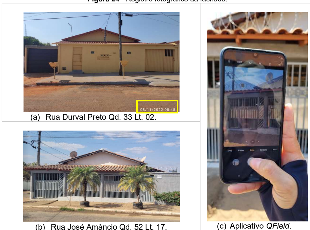
Figura 24 - Registro fotográfico da fachada.
