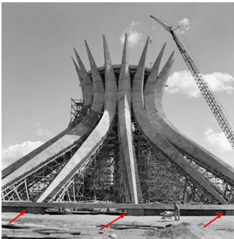
Figura 40 - Apoio da superestrutura nas placas de Neoprene
