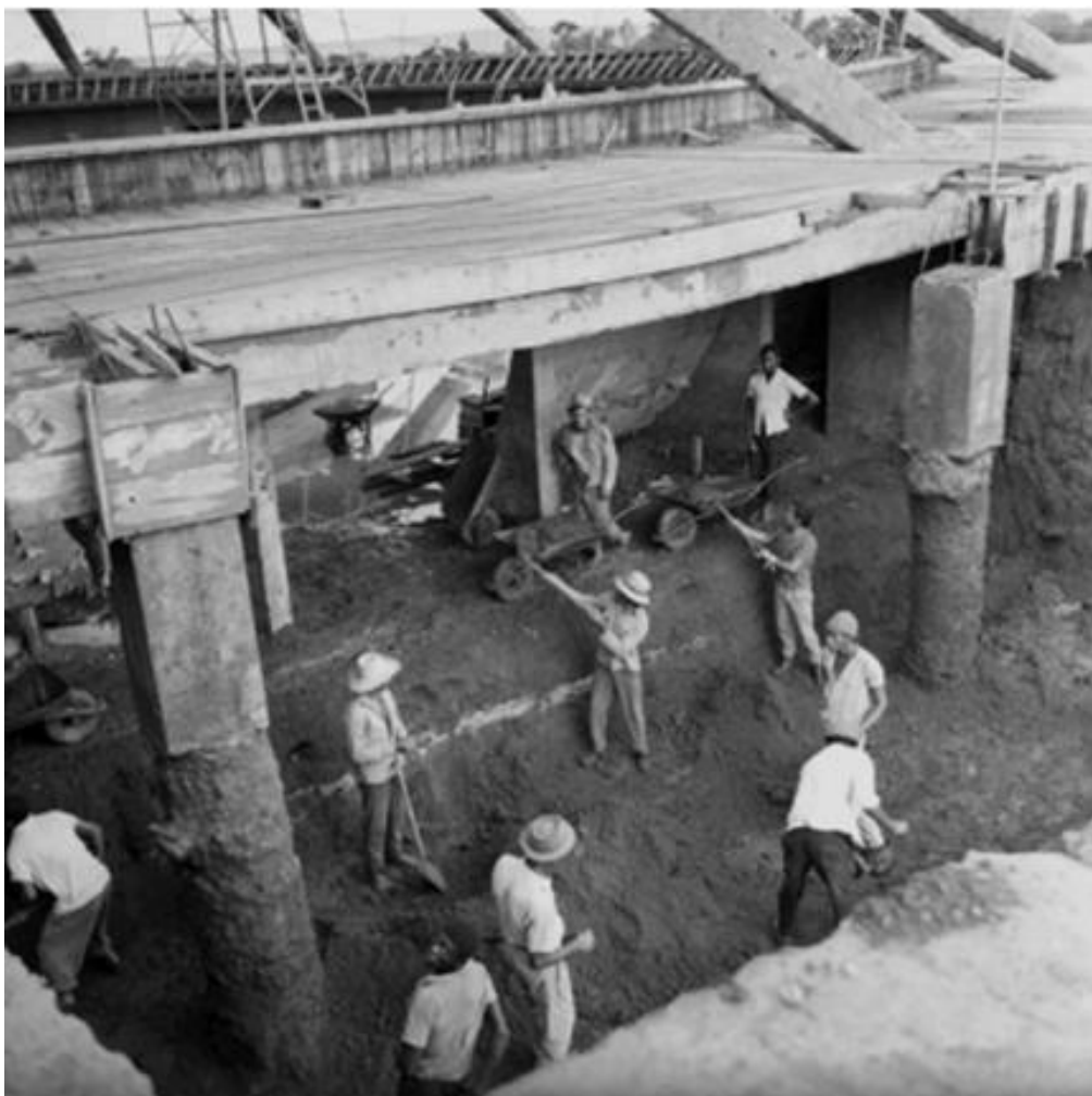
Figura 49 - Operários trabalhando na escavação sendo visível os pilares da galeria técnica da Catedral de Brasília em 1960
