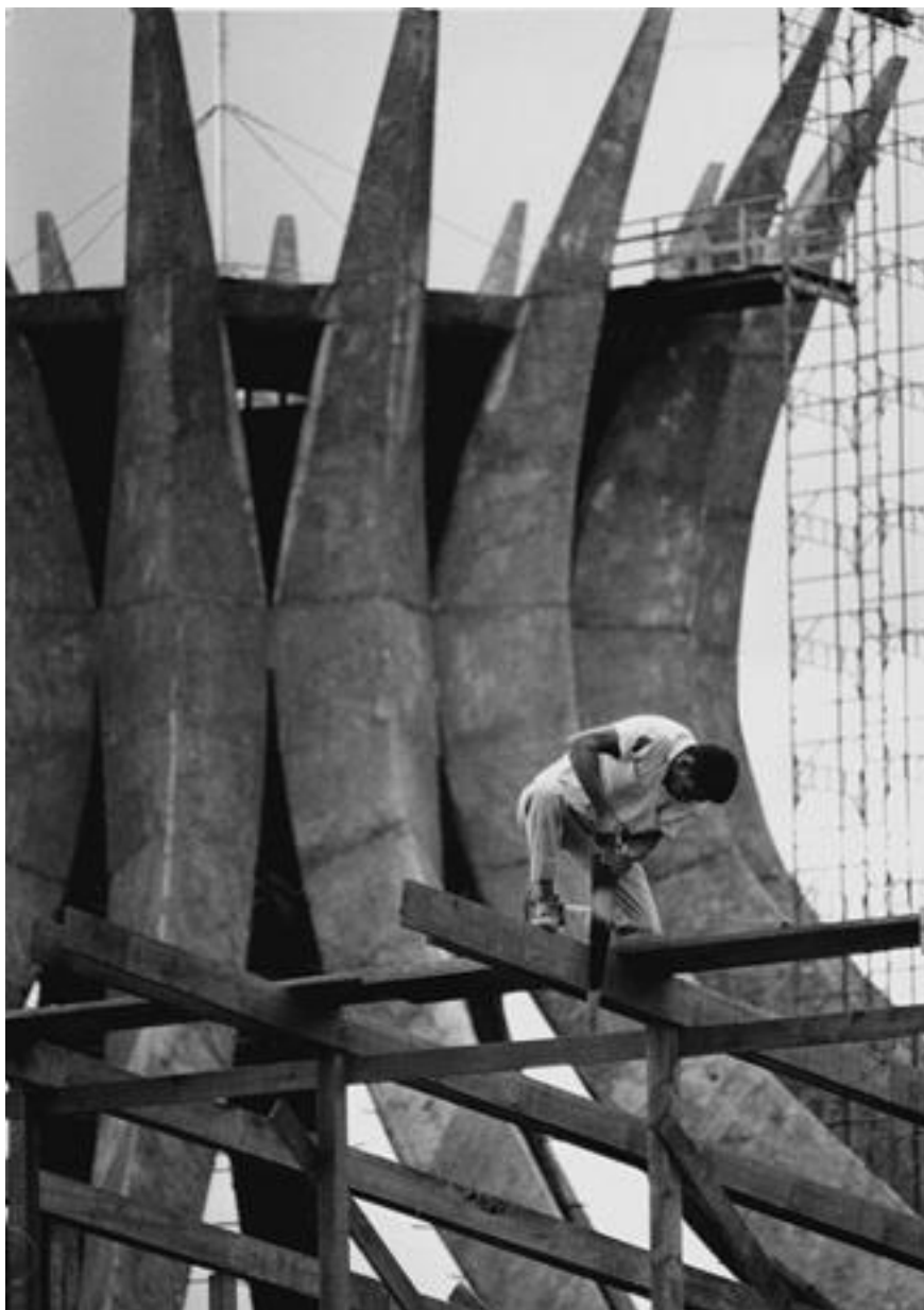
Figura 50 - Operários trabalhando na construção da Catedral de Brasília
