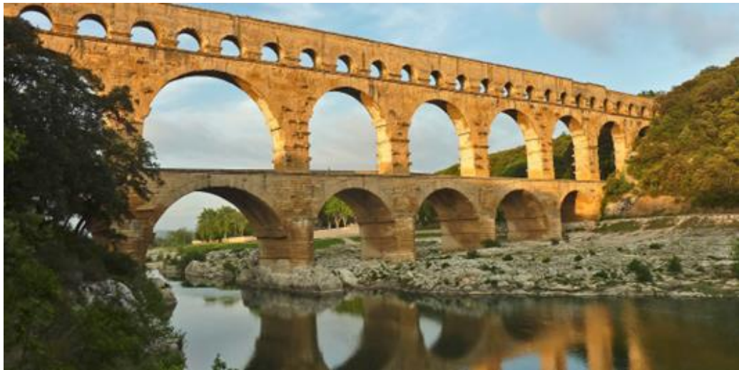
Figura 6 - Aqueduto Romano revestido com Pozzolana
