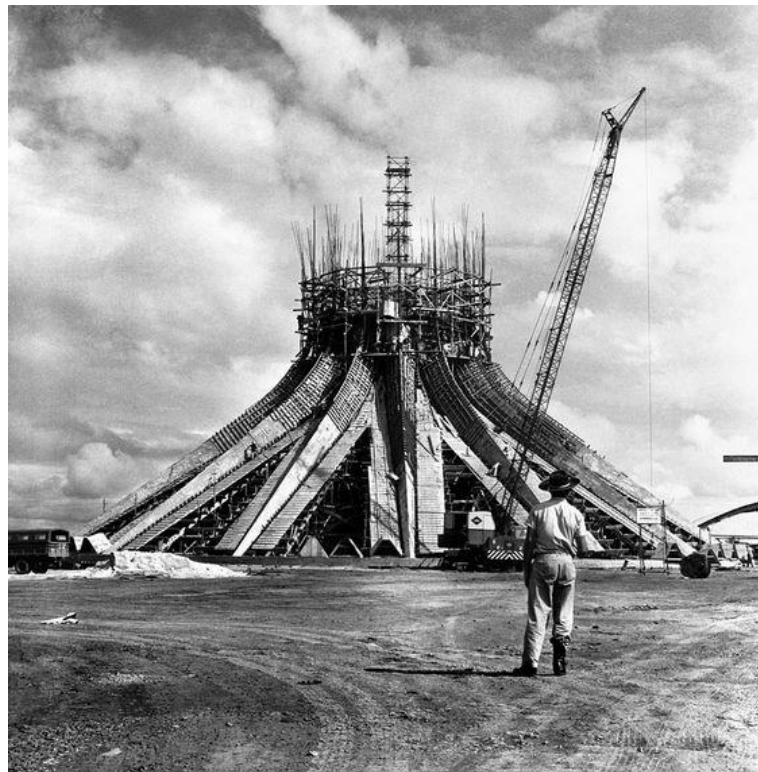
Figura 46 - Lançamento de concreto nos pilares da Catedral de Brasília
