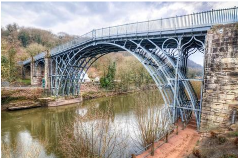
Figura 16 - A ponte do ferro sobre o rio Severn, Inglaterra
