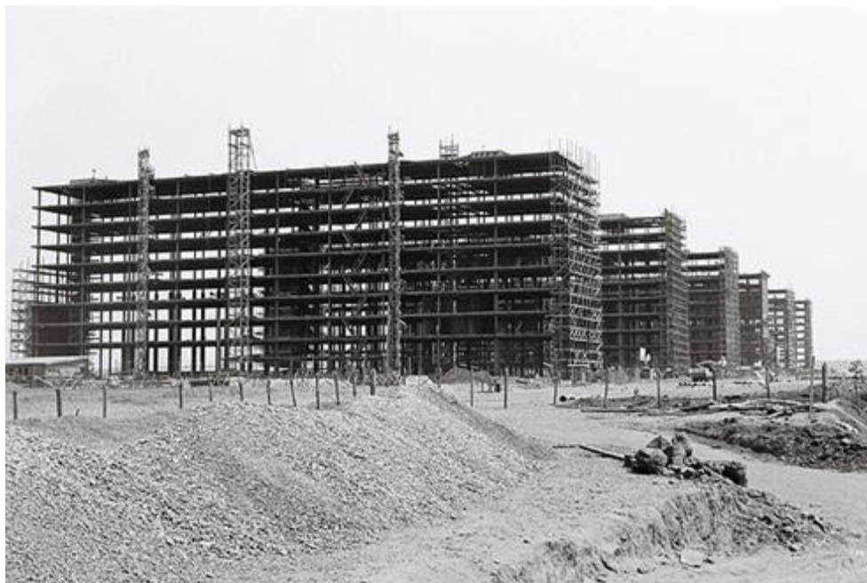
Figura 26 - Esplanada dos ministérios em construção
