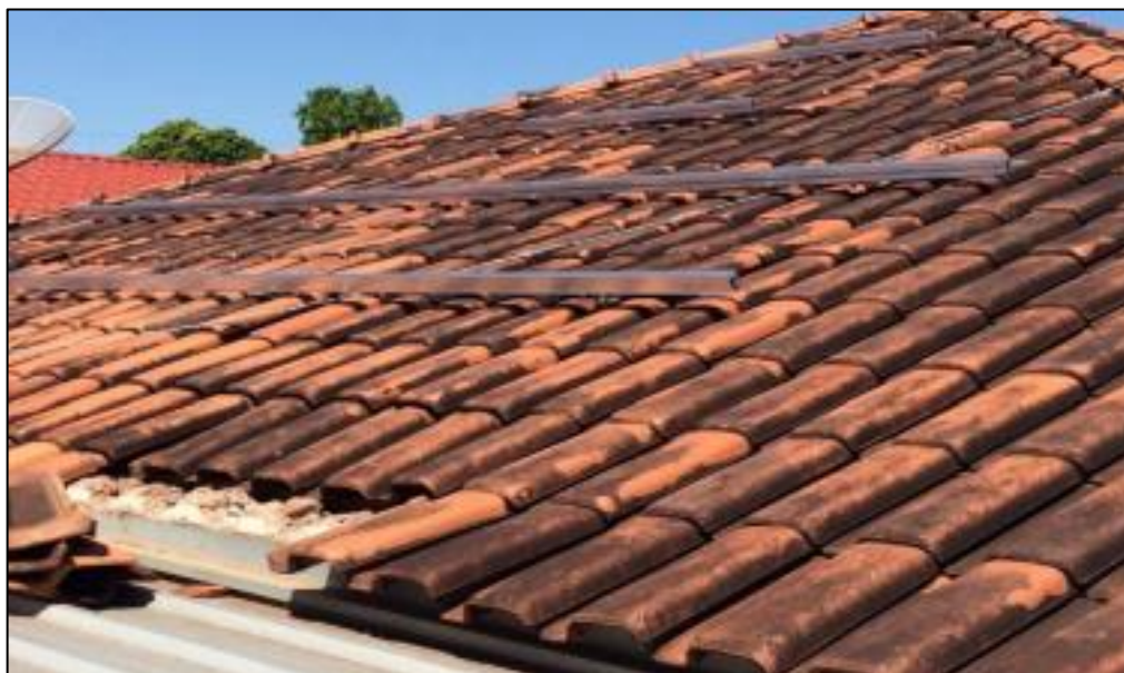
Figura 72: Fixação de perfis em telhado cerâmico
