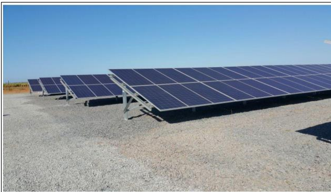
Figura 70: Aplicação Estrutura de solo.
