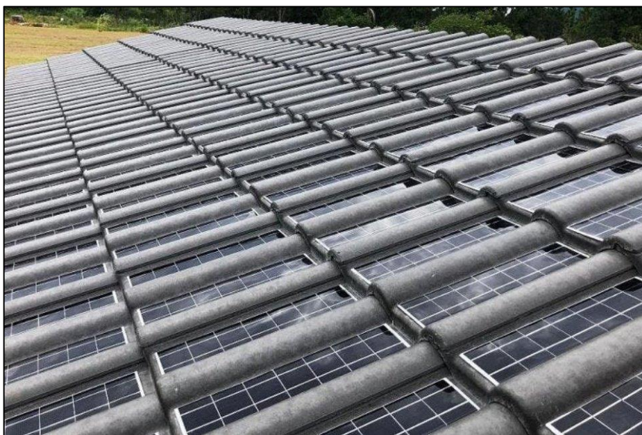
Figura 28: Telha fotovoltaica.
