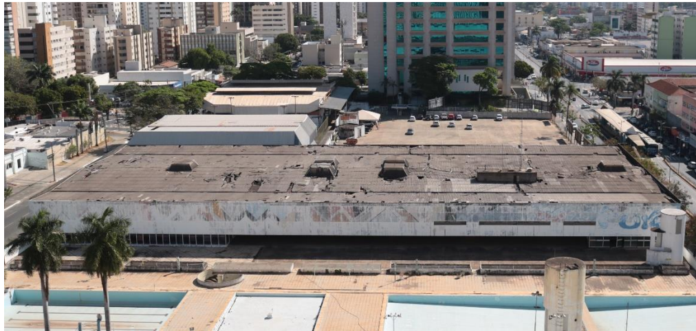
Figura 26 – Visão geral da parte superior da cobertura.
