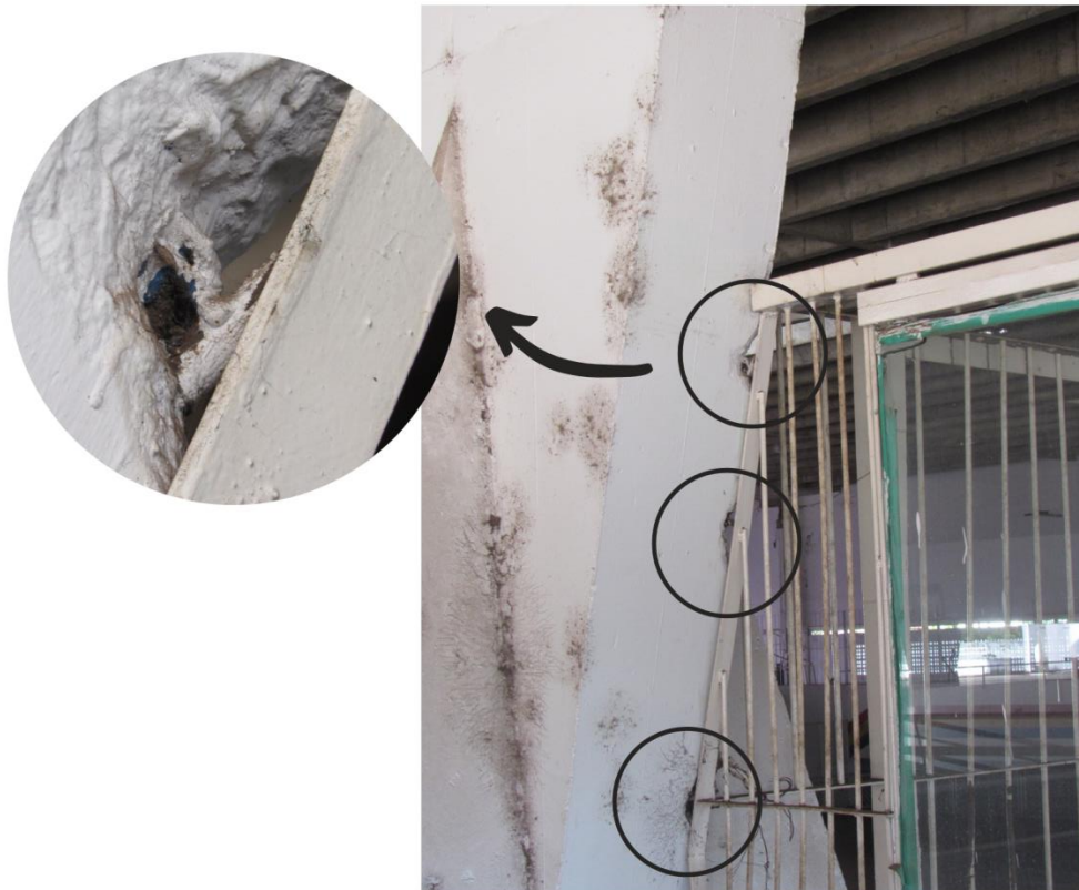
Figura 47 – Instalação de portão metálico no Pilar 14.
