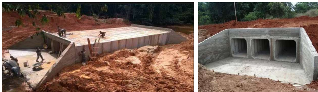
Figura 2 - Bueiro Triplo Celular de Concreto – BTCC
