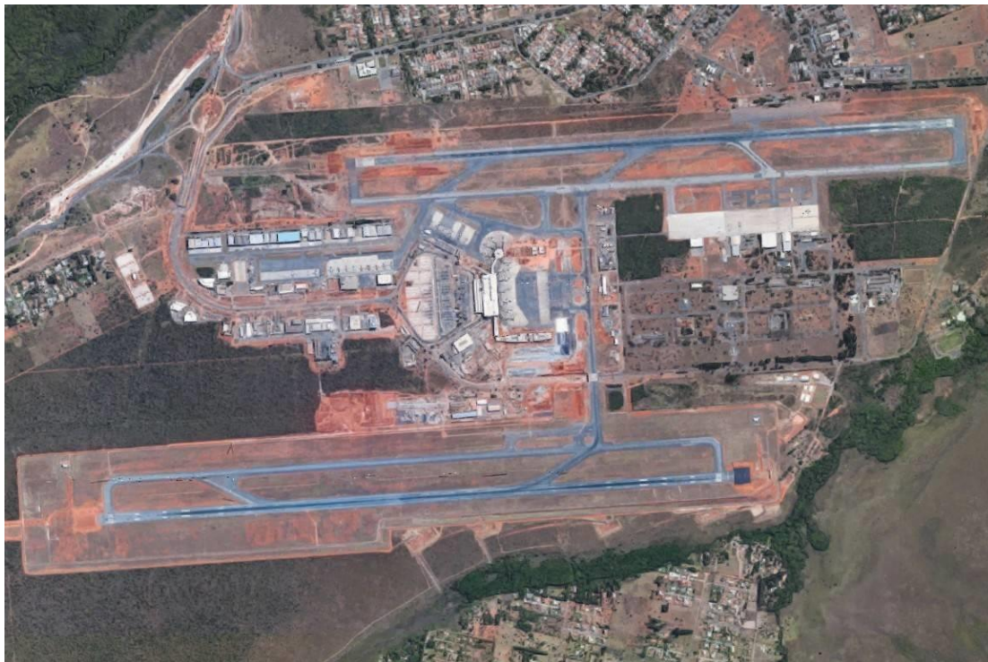
Figura 5- Construção das duas pistas paralelas de voo (GAZETA DO POVO, 2022).
