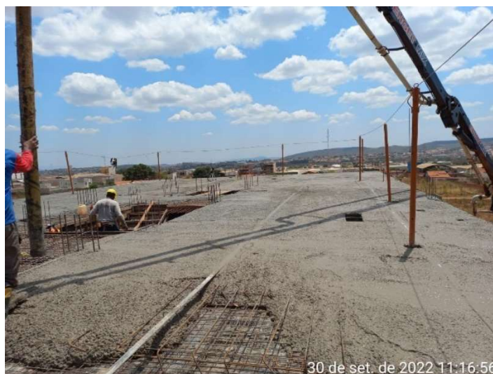
Figura 18 - Concretagem de laje maciça
