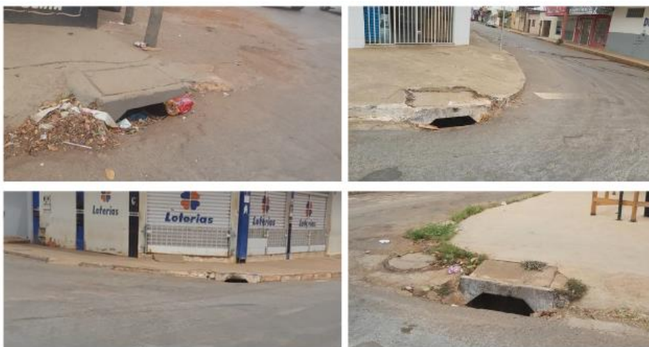
Figura 43- Bueiros de esquinas (Trecho 01)
