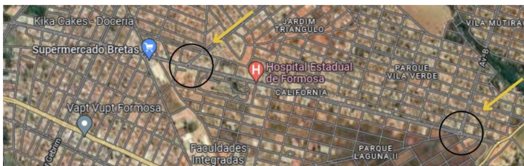
Figura 34- Rotatórias com presenças de corrugação
