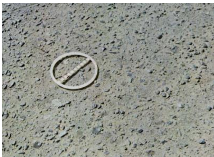
Figura 21 - Desgaste
