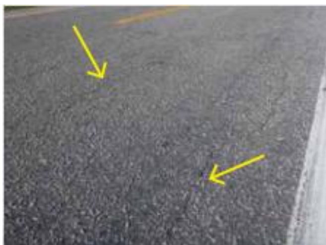
Figura 10 – Fissura
