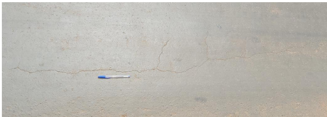
Figura 27- Fissura longitudinal
