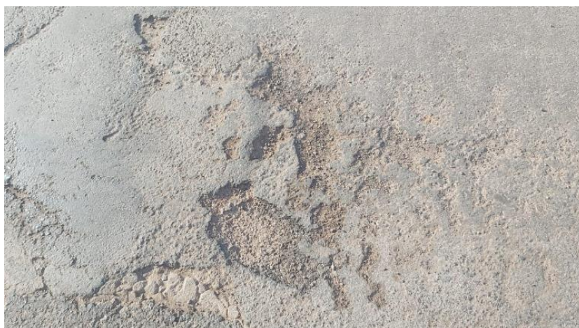
Figura 38 – Desgaste
