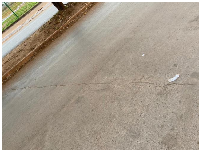
Figura 28- Trinca Transversal
