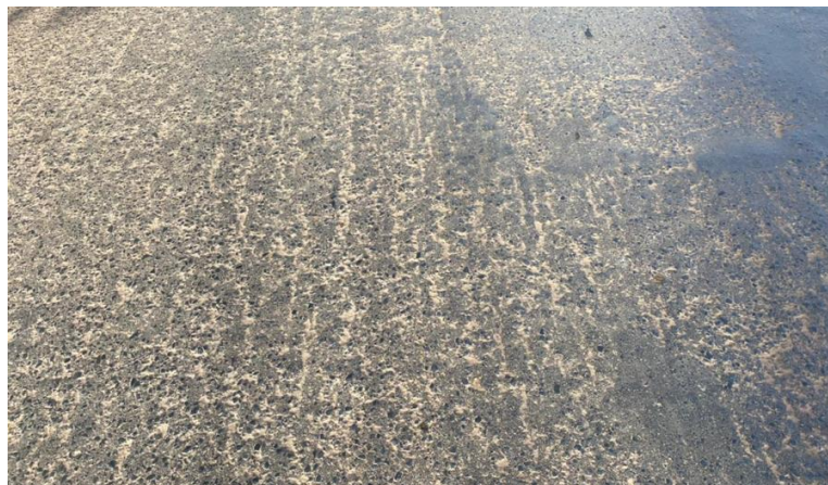
Figura 37- Desgaste
