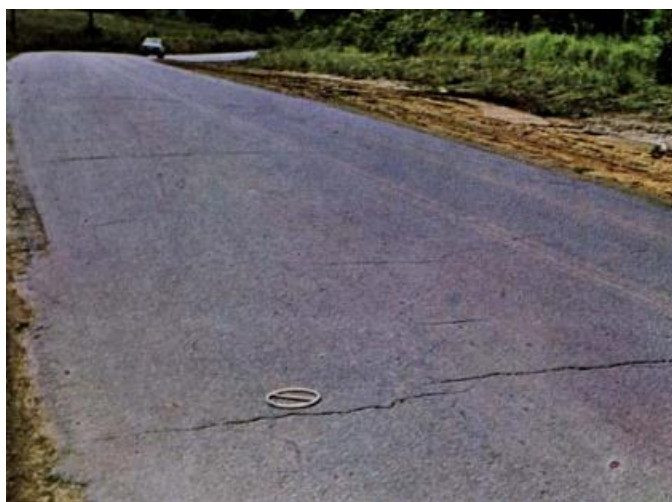
Figura 11 - Trinca Transversal
