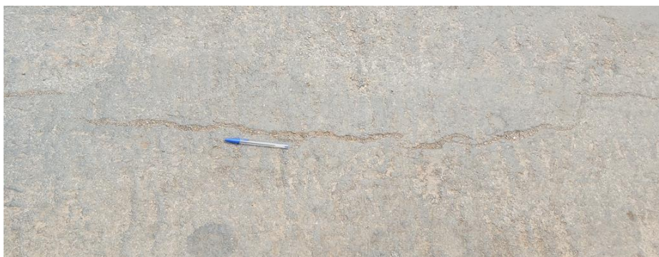
Figura 29- Trinca Longitudinal
