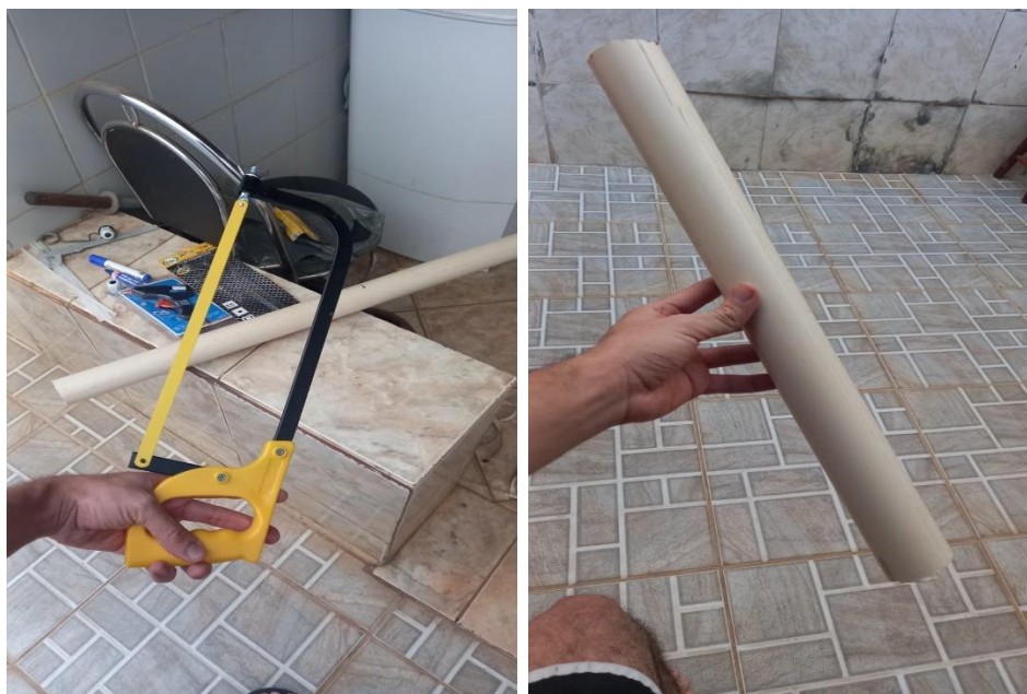
Figura 23 - Corte no tubo de PVC
