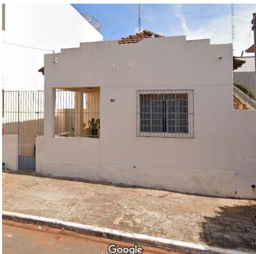
Figura 4.15 – Edificação localizada no Setor Centro, infraestrutura antiga com padrão construtivo baixo.
