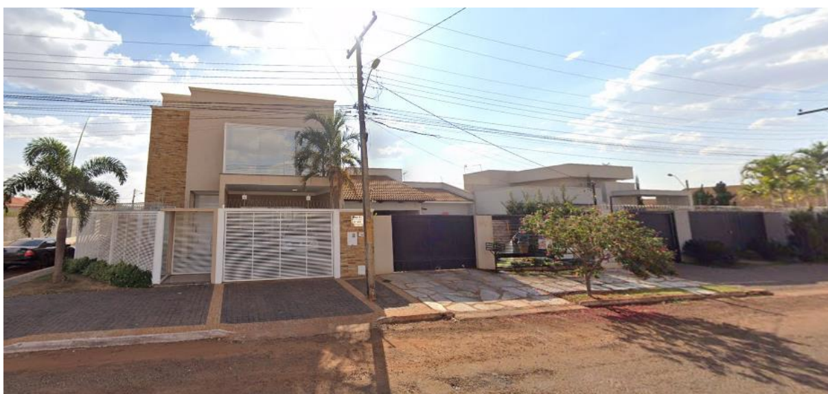
Figura 4.17 – Edificações localizadas no Setor Morada do Sol, infraestrutura de padrão construtivo alto.
