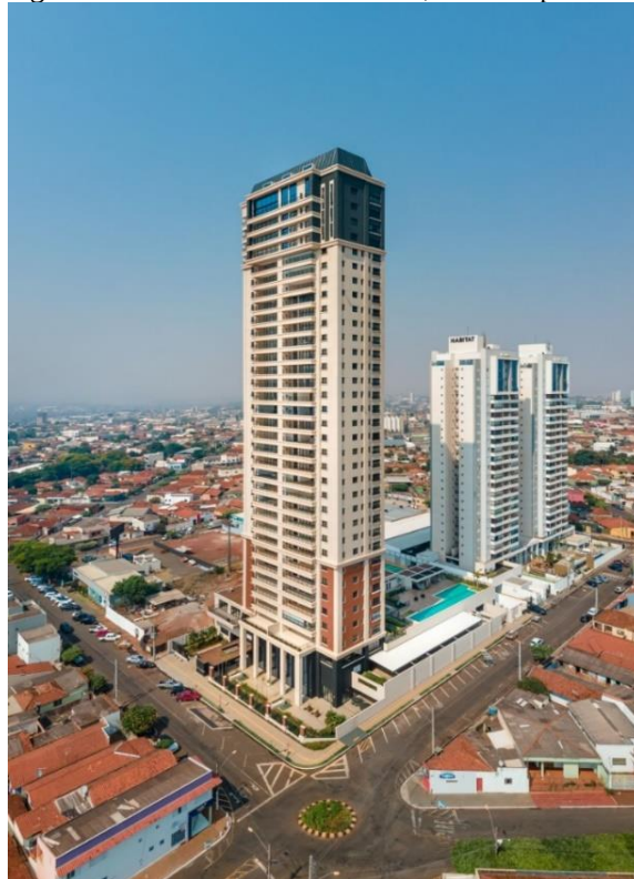
Figura 6 – Vista aérea dos edifícios, tratados por PGV
