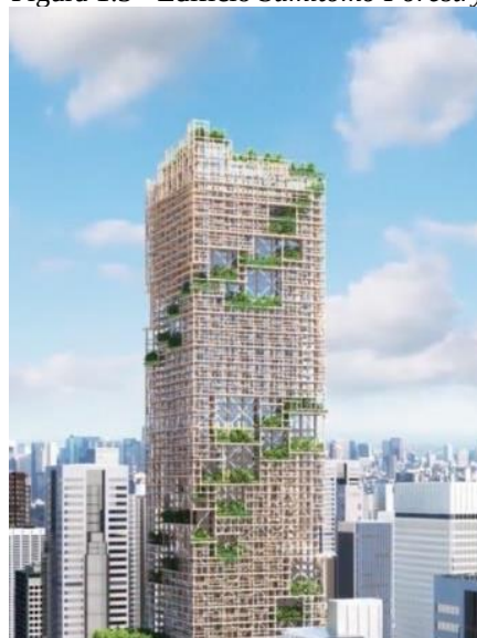
Figura 1.3 - Edifício Sumitomo Forestry
