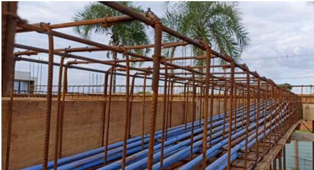
FIGURA 18 – Viga com os cabos de protensão.
