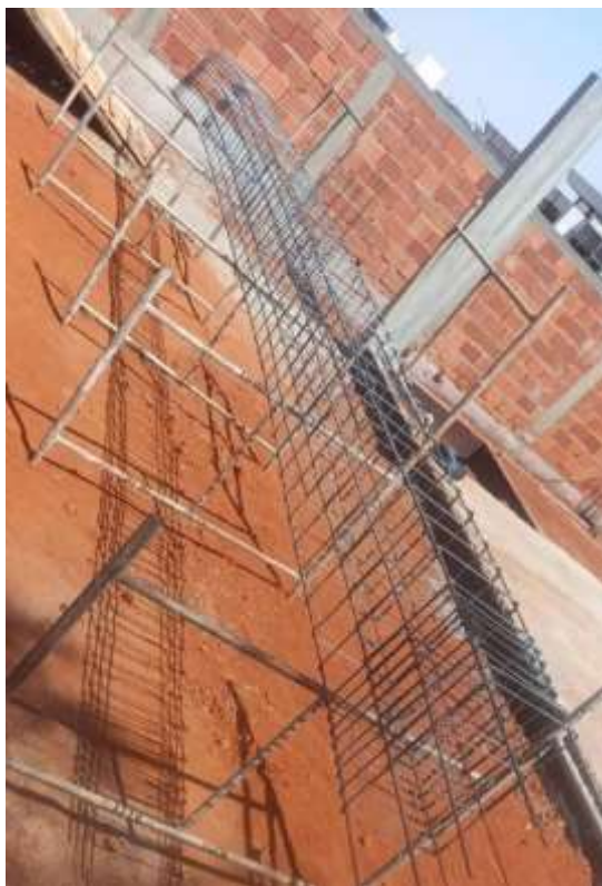
FIGURA 16 – Armadura da viga.
