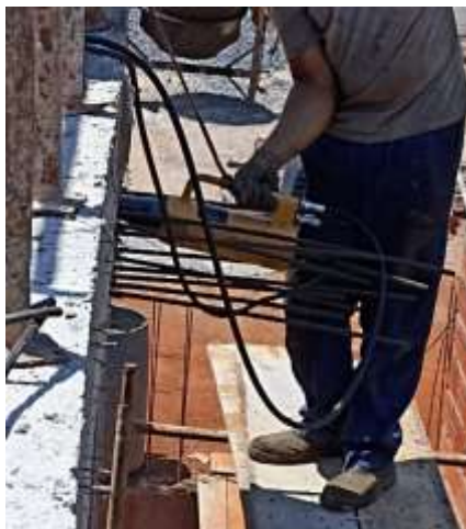
FIGURA 21 – Protensão da viga 202.
