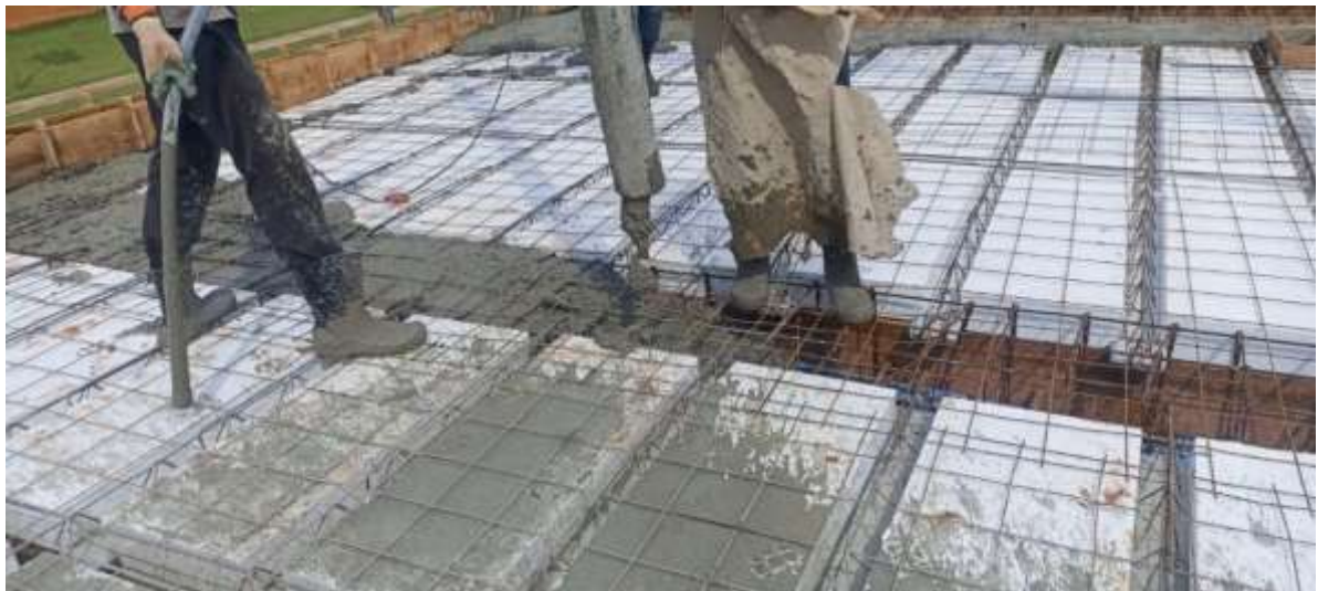
FIGURA 19 – Concretagem da viga.
