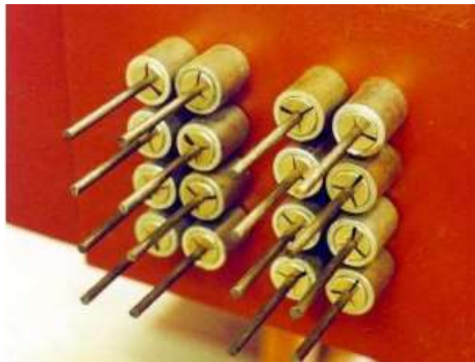
FIGURA 05 - Ancoragem com cunhas.
