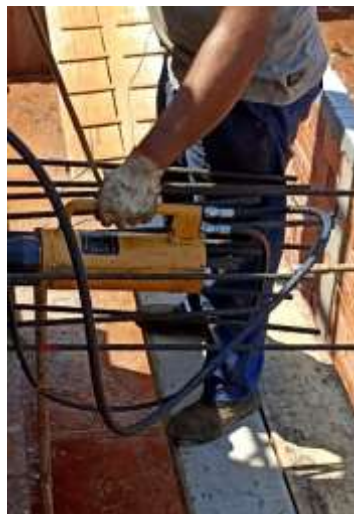
FIGURA 20 – Protensão da viga 203.
