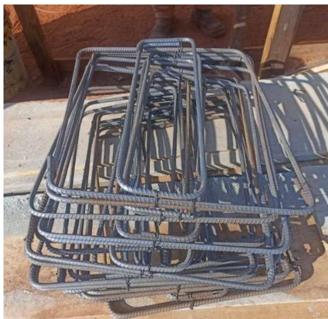
FIGURA 17 – Estribos da viga.
