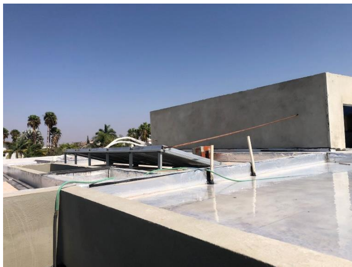
Figura 19 – Laje da cobertura com a utilização das vigas semi-invertidas
