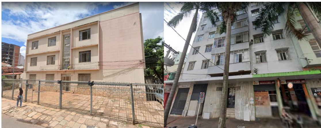
Figura 5 - Edifícios Pioneiro e Concórdia no Setor Central de Goiânia
