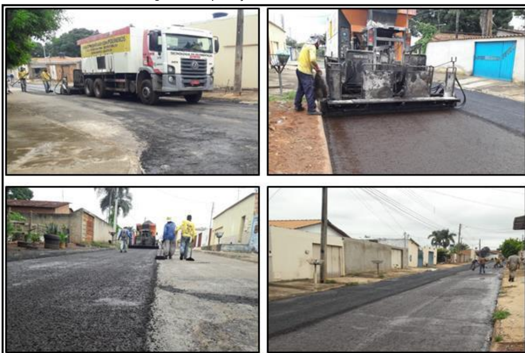
Figura 5 - Aplicação de Microrrevestimento
