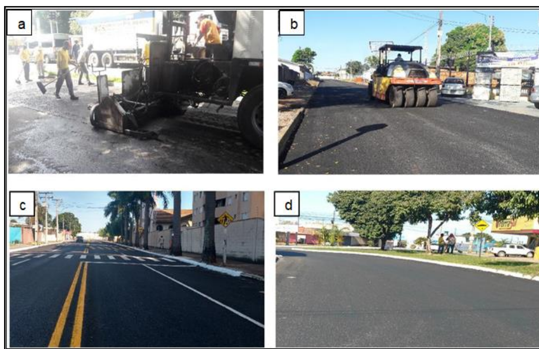
Figura 6 – Correções (a), adensamento (b), sinalização (c) e limpeza (d), respectivamente
