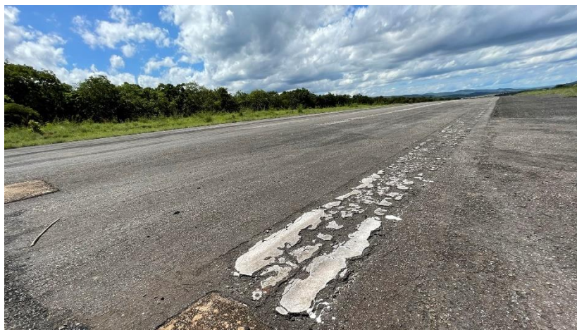
Figura 43 – Remendo com desnível em PPD
