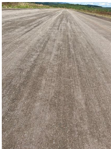
Figura 47 – Desgaste superficial na PPD
