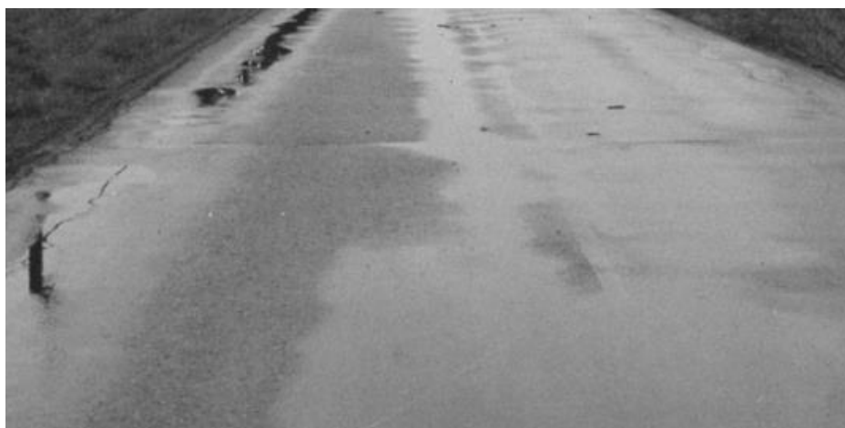
Figura 23 – Fluência em extremidade de via pavimentada
