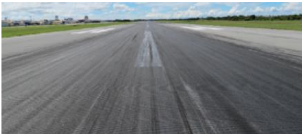
Figura 31 – Grooving em PPD colmatado por borracha
