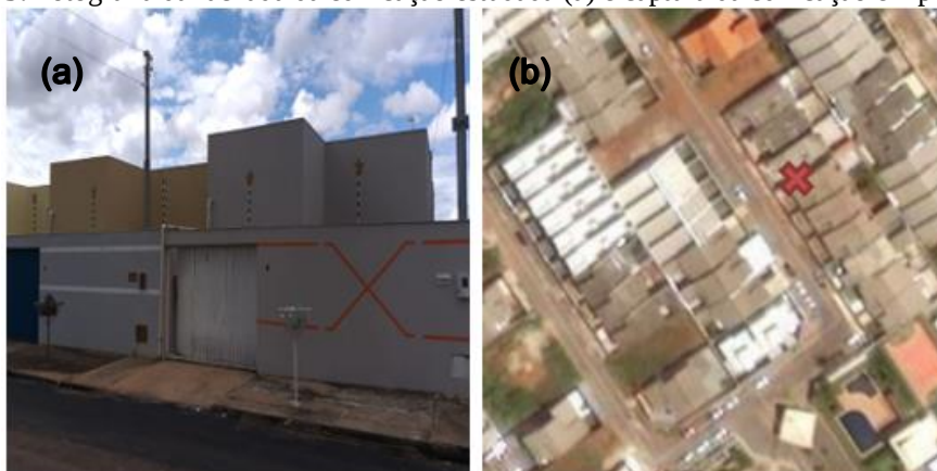
Figura 3: Fotografia da fachada da edificação estudada (a) e captura da edificação em planta (b).
