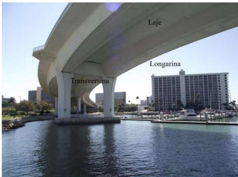
Figura 1 – Superestrutura da ponte Clearwater Memorial Causeway, Flórida
