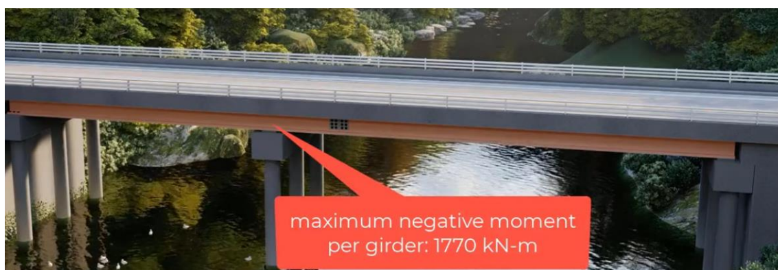
Figura 78 – Máximo Momento Negativo no Apoio em B
