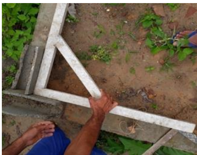
Figura 21: Instrumento utilizado na construção do alicerce: Esquadro
