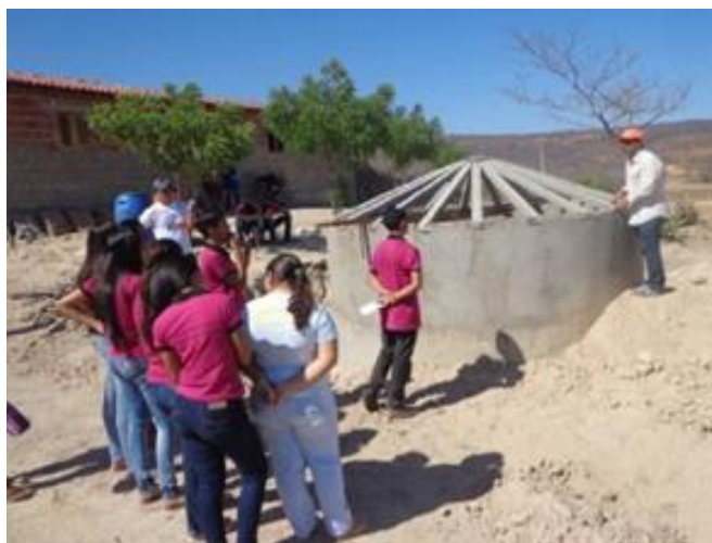
Figura 19: Investigadores identificando elementos matemáticos na construção de cisternas
