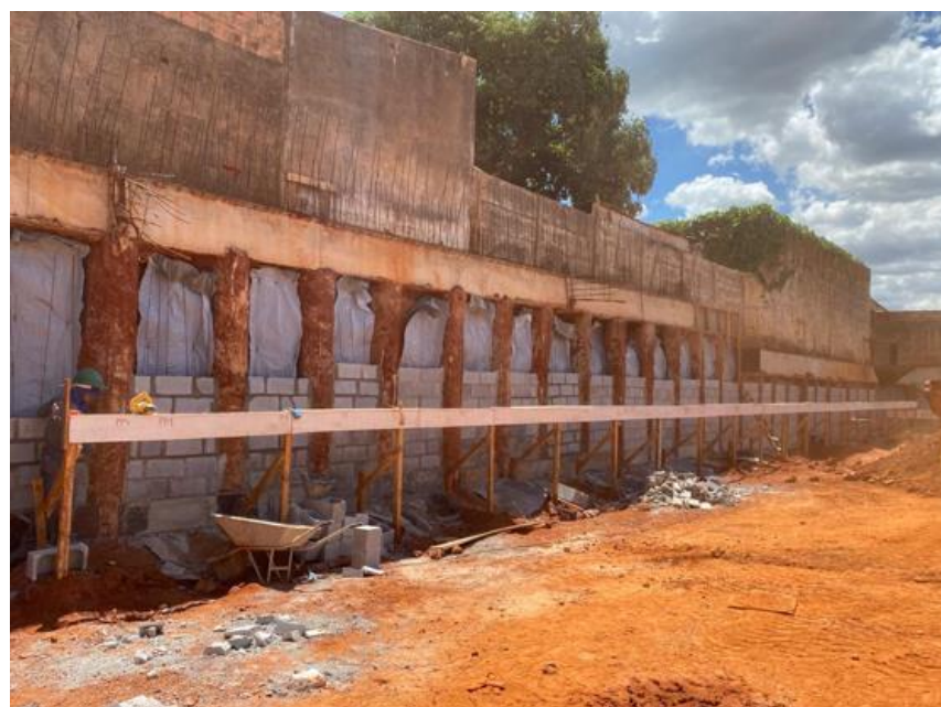
Figura 10 – Representação da execução de serviços de contenção
