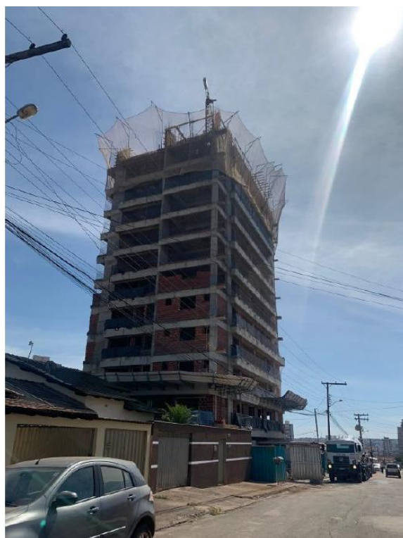
Figura 07 – Representação da execução da Obra 01 atualmente (maio/2022)
