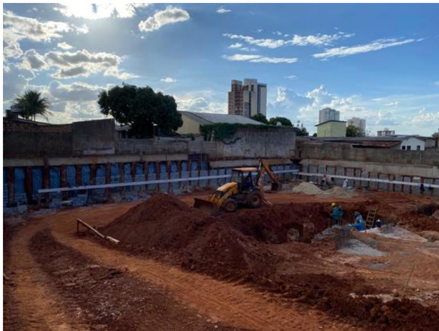
Figura 11 – Representação da execução de serviços de contenção
