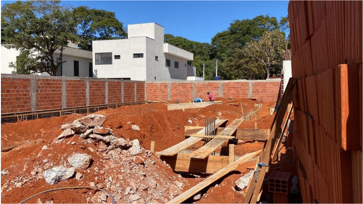
Figura 14 – Representação da execução da Obra 02 atualmente (maio/2022)
