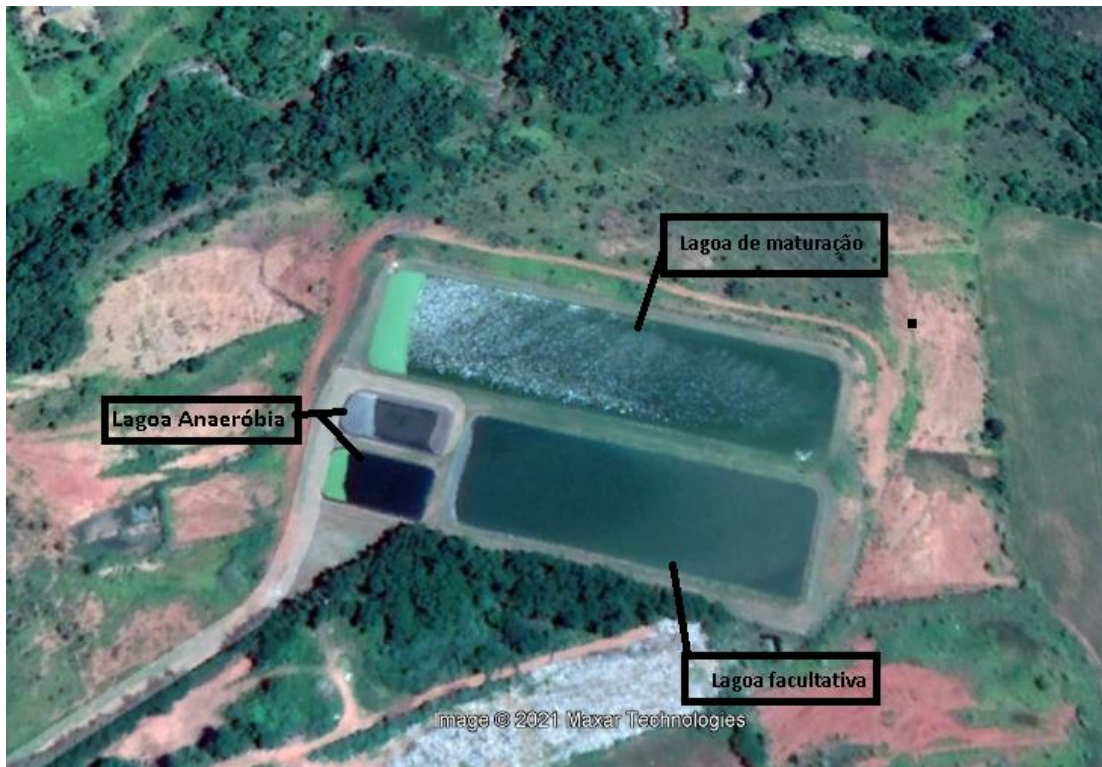
Figura 4 - Lagoas de estabilização da ETE de Abadiânia
