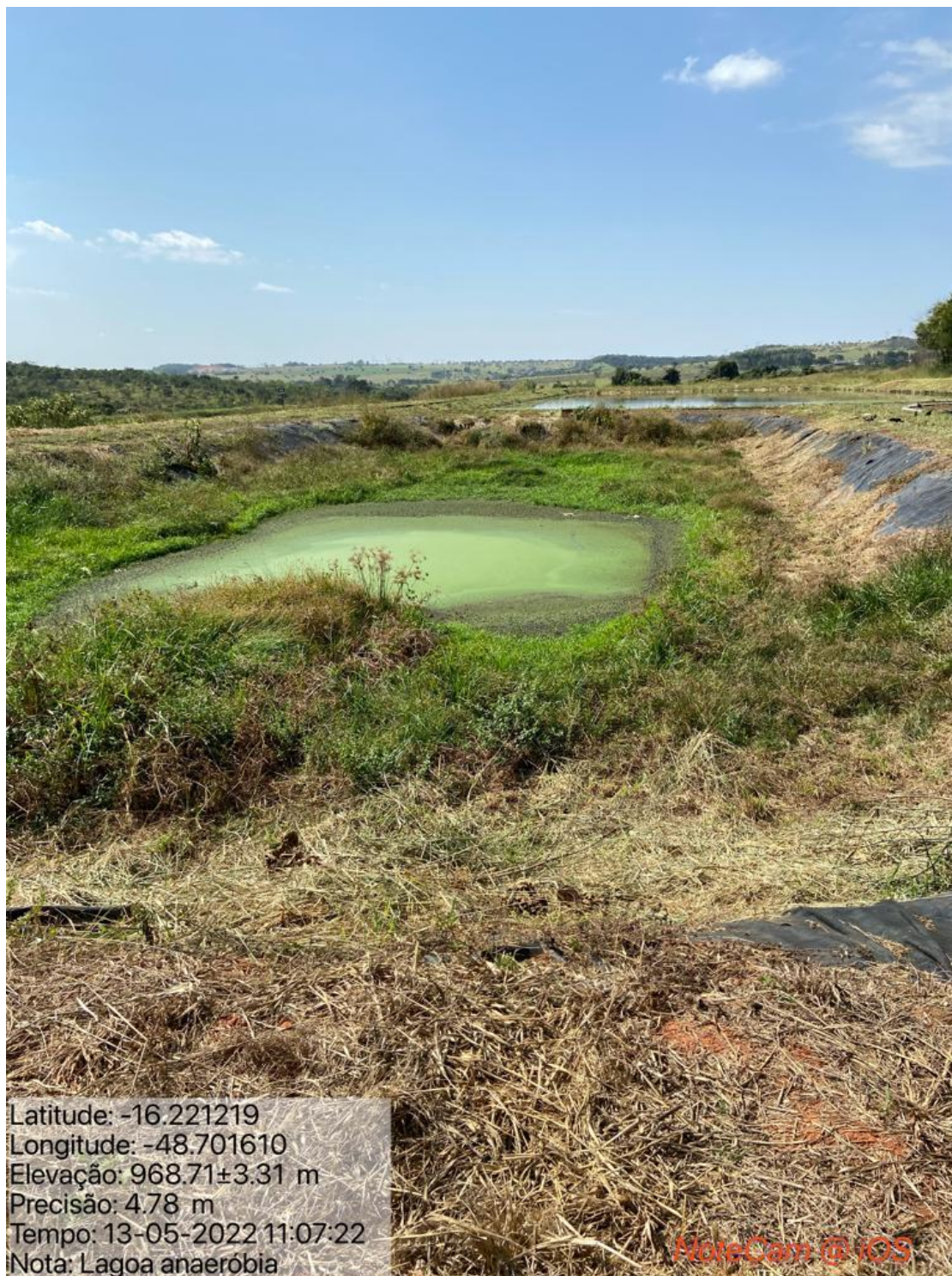
Figura 11 - Lagoa Anaeróbia Desativada
