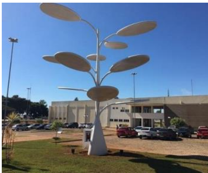
Figura 2 – Usina Fotovoltaica em formato de árvore
