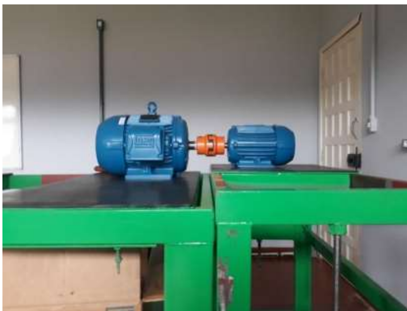
Figura 07- Bancada de suporte com acoplamento das máquinas assíncronas.
