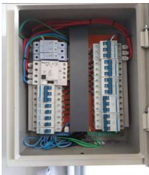
Figura 08- Quadro de Distribuição de Cargas.
