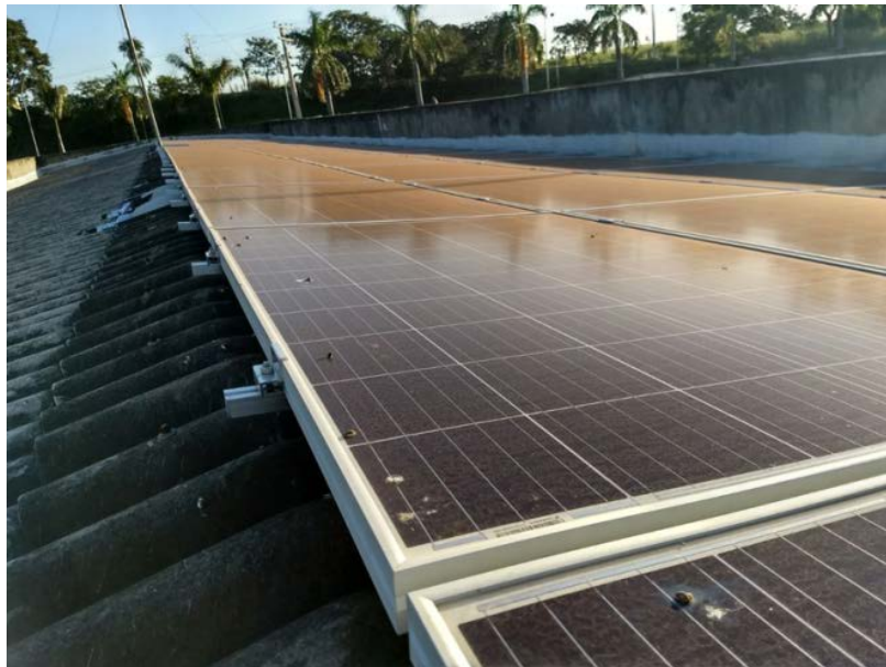
Figura 8 – Sujeira observada nos Módulos no IFG (BLOCO 500) (Arquivo Pessoal)
