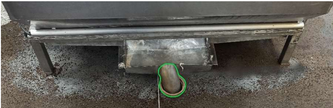
Figura 23 - Adaptação da tubulação desejada.
