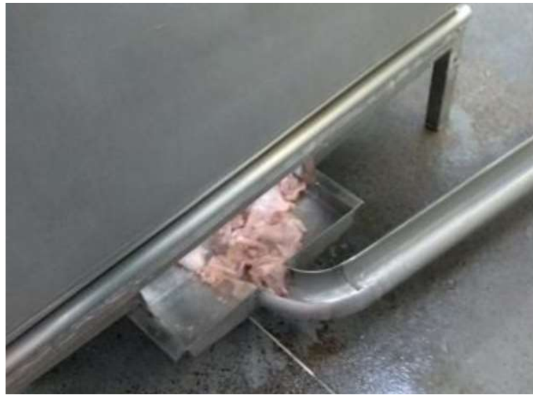
Figura 24 - Retenção de material.
