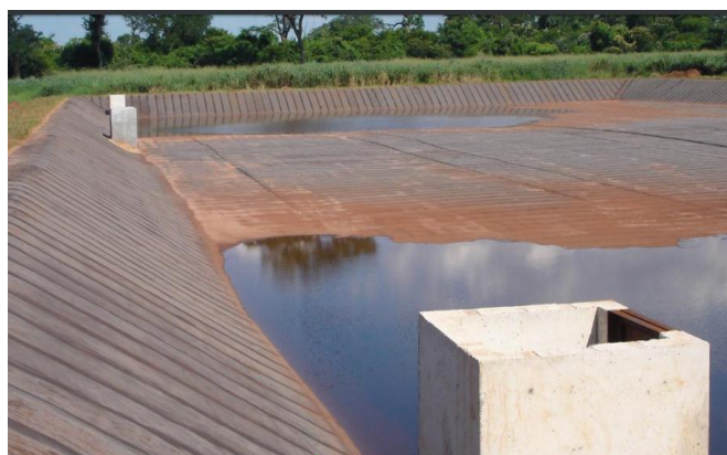
Figura 5: Tanque revestido com Manta Asfáltica.
