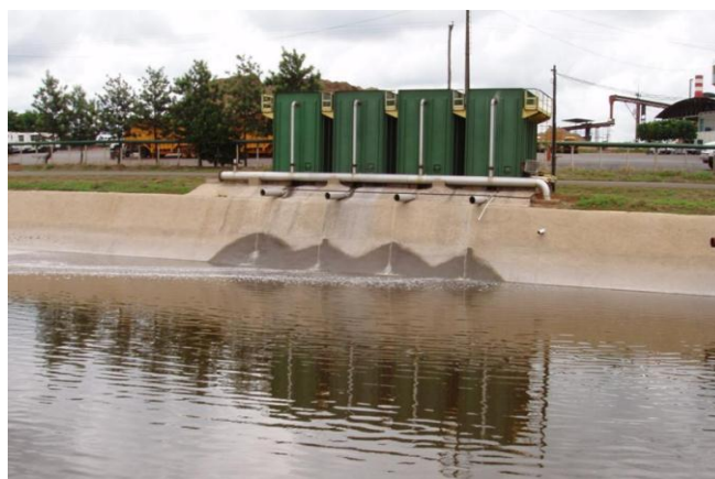
Figura 7: Tanque revestido com Cimento.
