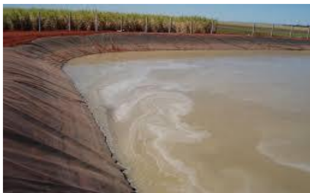
Figura 4: Tanque revestido com PEAD.
