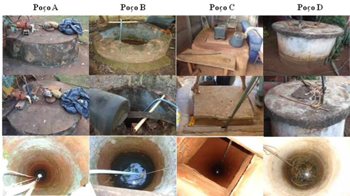
Figura 3 - Aspectos da estrutura interna e externa dos quatro poços escavados da zona rural circunvizinha ao aterro controlado de Itumbiara-GO utilizados para coleta de amostras de água
