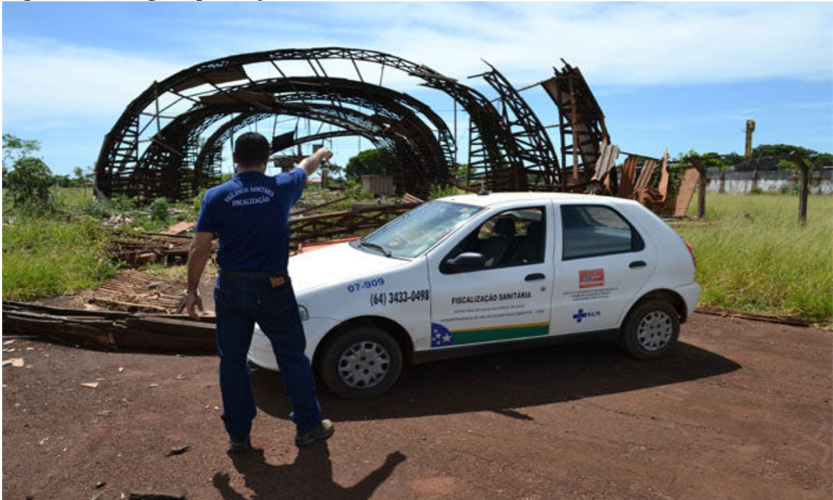
Figura 4 – Antigo depósito judiciário de Itumbiara-GO
