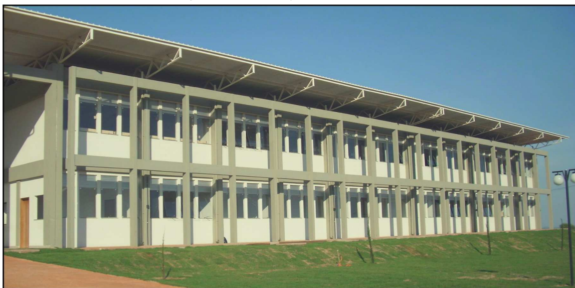
Figura 2 - Construção do IFG-Anápolis
