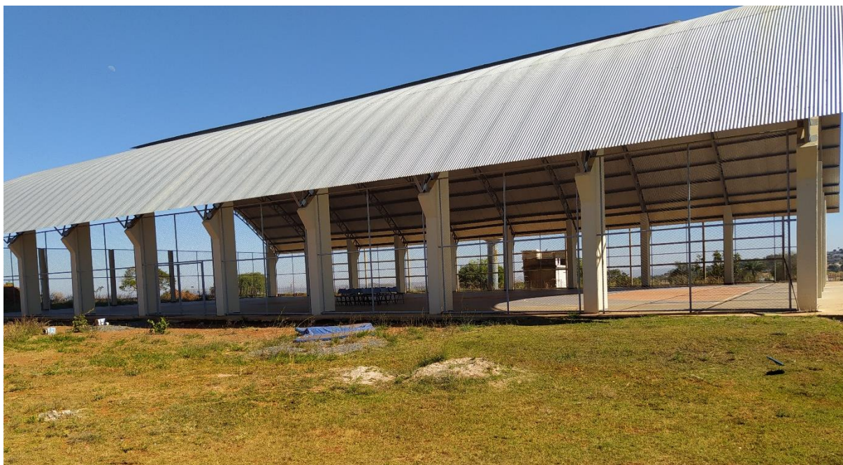
Figura 63 – Quadra poliesportiva coberta do Campus Anápolis
