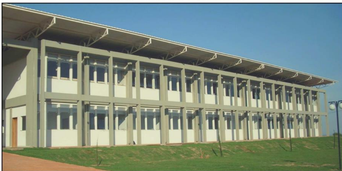
Figura 2 - Construção do IFG-Anápolis
