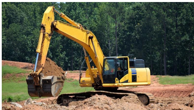
Figura 8: Escavação na obra
