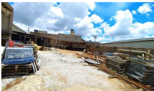
Figura 22: Canteiro de obra e estocagem de materiais.
