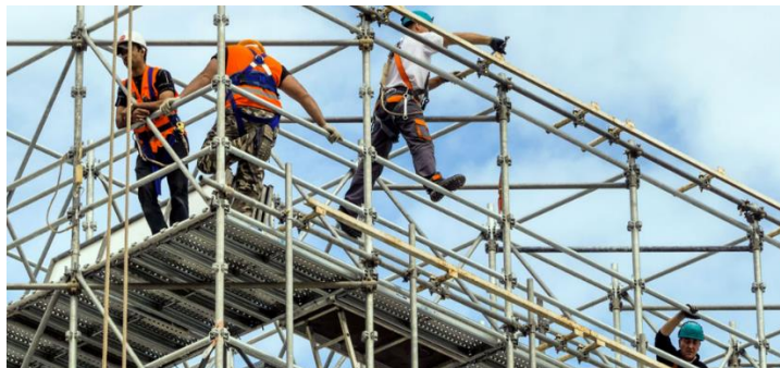
Figura 12: Andaime e plataformas de trabalho
