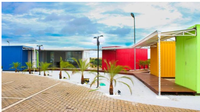
Figura 5: Área de vivência canteiro de obra
