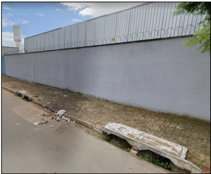
Figura 14 – Foto das bocas de lobo de guia com depressão na rua Niterói.
