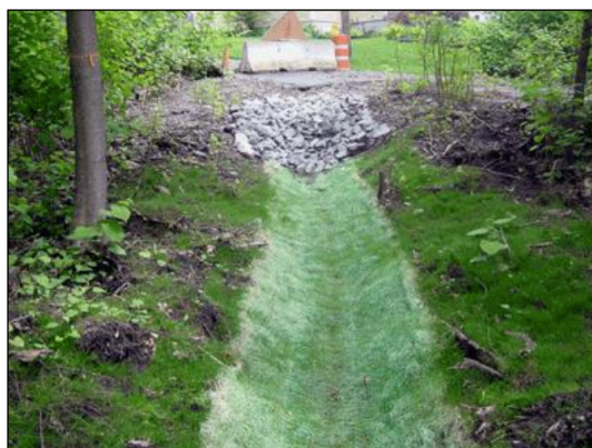
Figura 17 – Vala de infiltração
