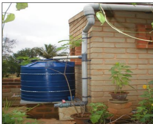
Figura 17 – Reservatório de retenção
