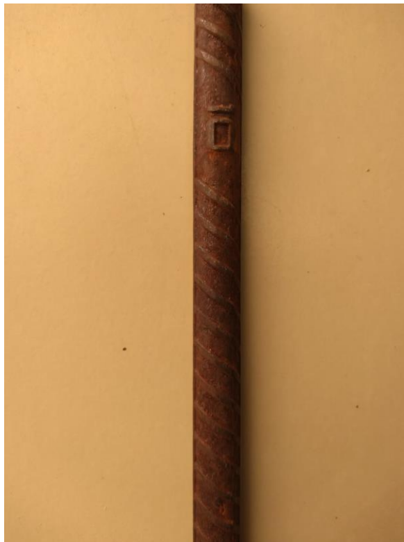
Figura 3.5 - Barra Gerdau 10mm com marcas de oxidação
