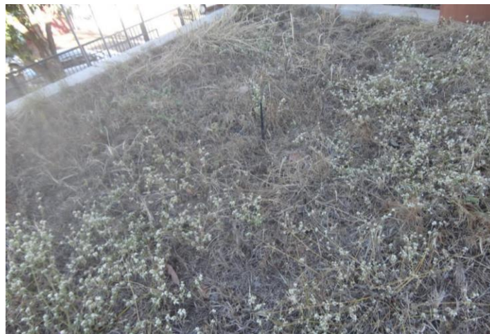
Figura 5 – Vegetação do telhado verde, após 8 anos, com presença de ervas daninhas
