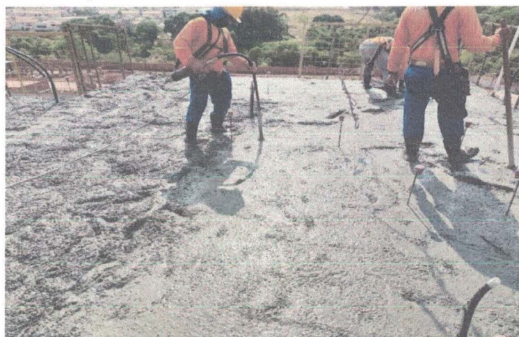
Figura 05 – Adensamento do concreto
