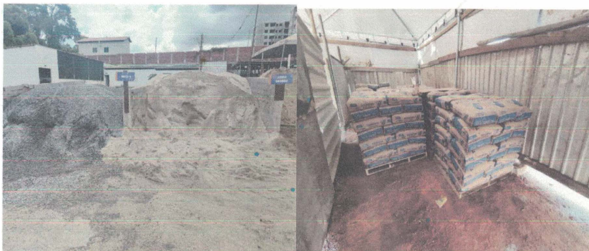
Figura 02 e 03 – Separação dos agregados do concreto.
