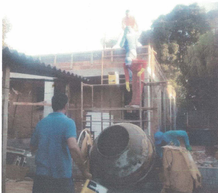
Figura 04 – Concretagem da estrutura
