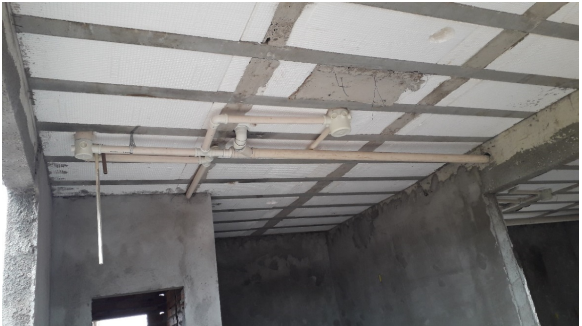
Figura 01 – Foto da estrutura já executada
