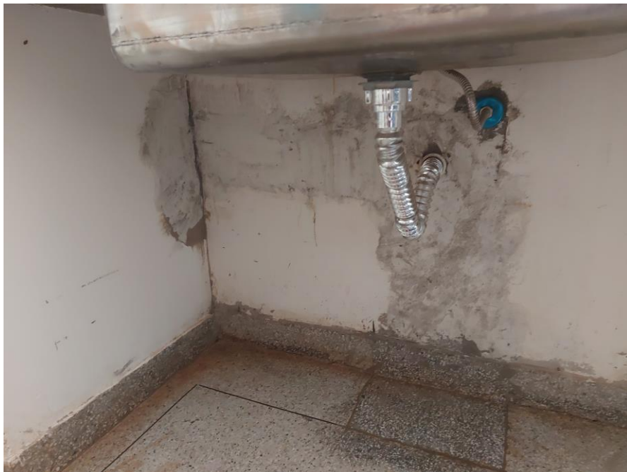
Figura 4.3 – Reparo por problema hidráulico
