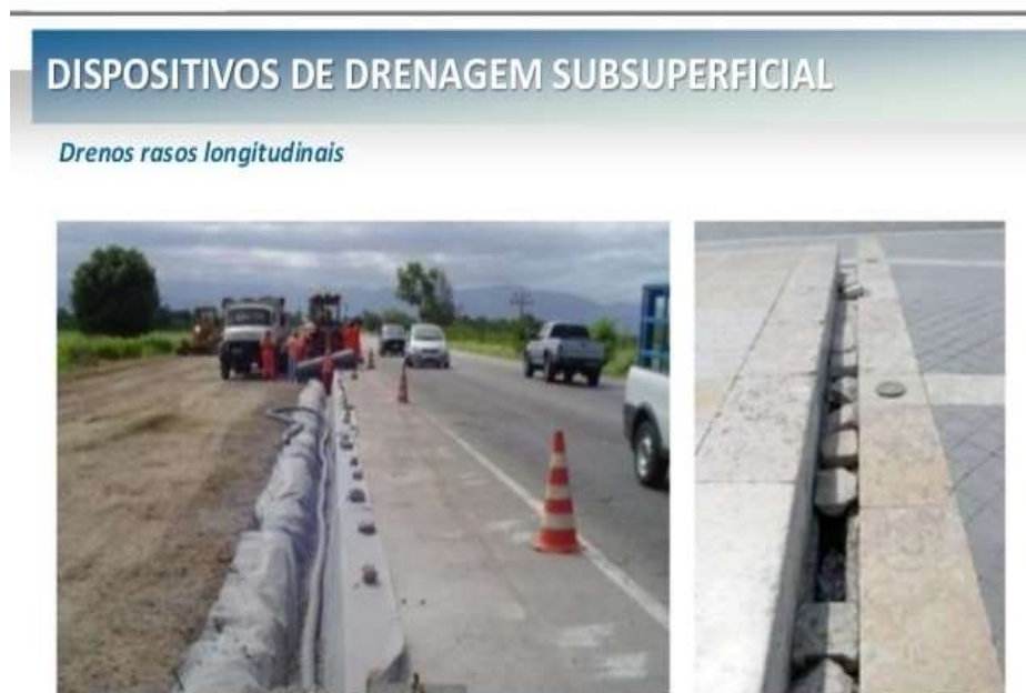
Figura 6: Drenos rasos longitudinais
