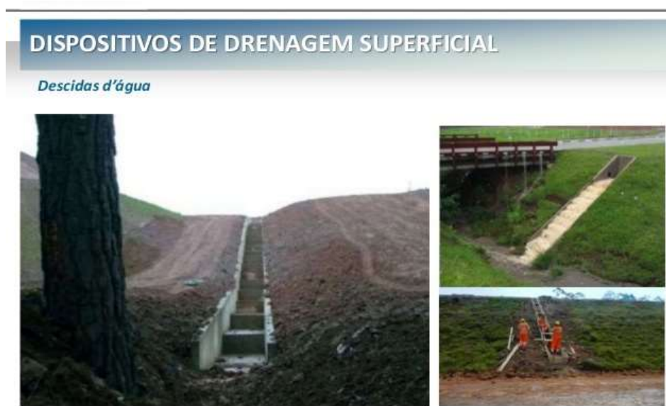
Figura 5: Descidas d' água
