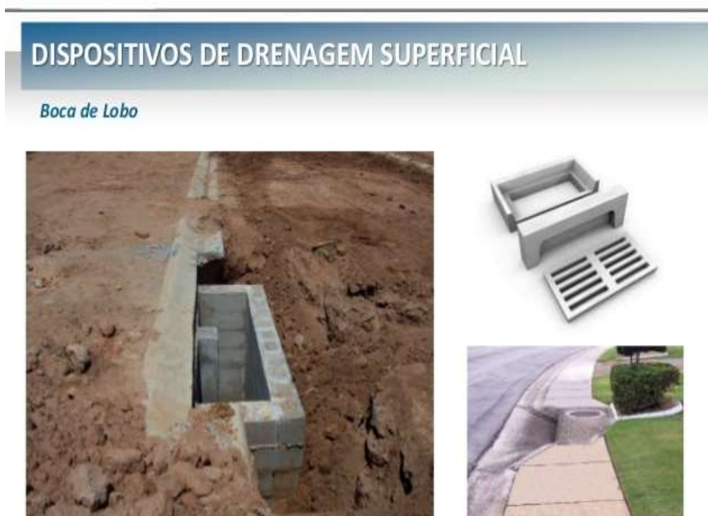
Figura 4: Boca de Lobo
