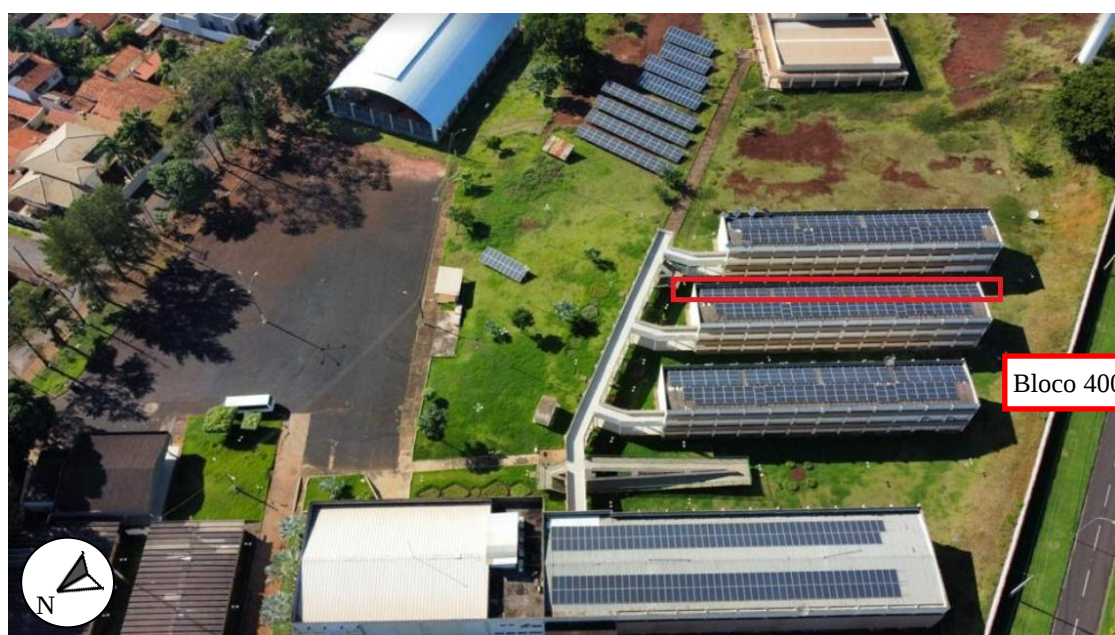
Figura 4.9: Vista aérea da usina solar do Câmpus Itumbiara do IFG.
