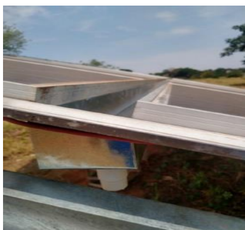
Figura 4.4: Calha de coleta da água de arrefecimento da string superior da planta piloto do Câmpus Aparecida de Goiânia do IFG. Fonte: MENDES, 2021.
