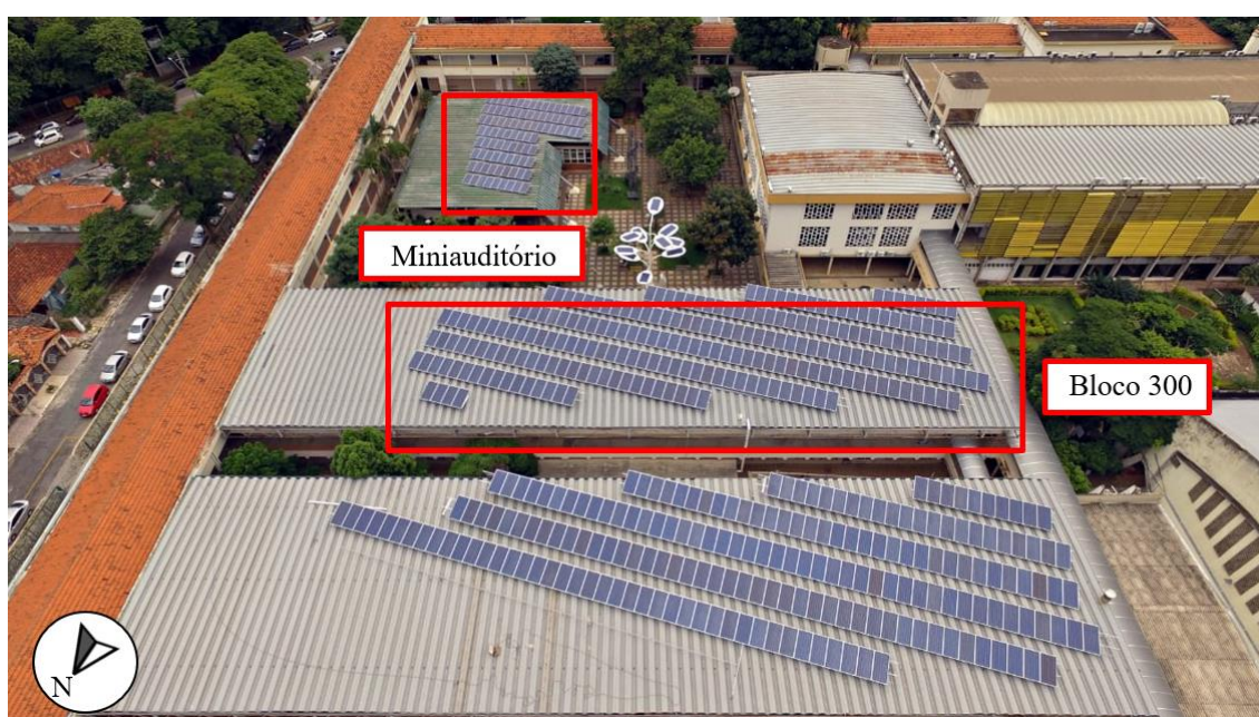
Figura 4.6: Vista aérea da usina solar fotovoltaica do Câmpus Goiânia do IFG. Fonte: 3E ENGENHARIA, 2020.
