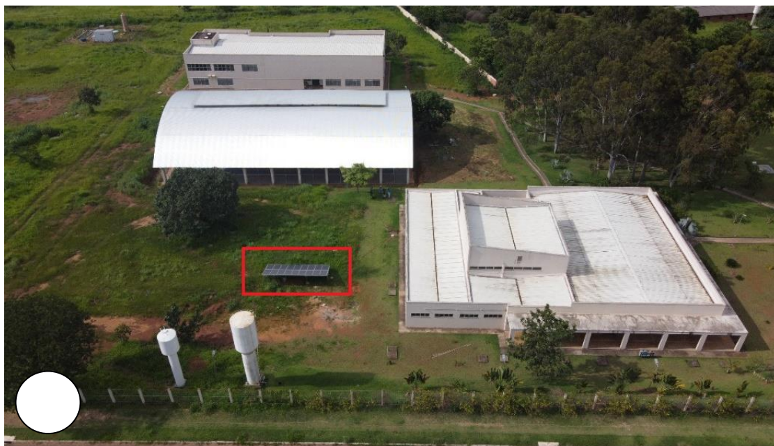
Figura 4.1: Vista aérea da microusina solar fotovoltaica do Câmpus Aparecida de Goiânia do IFG. Fonte: MENDES, 2021.
